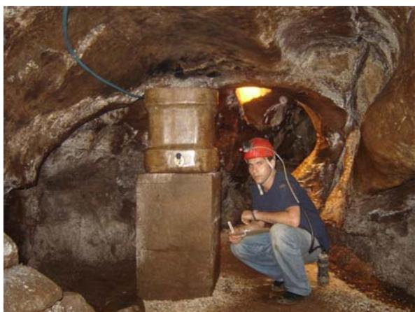
**Figura 17** - Caixa d'água para armazenar os gotejamentos provenientes da rocha.
