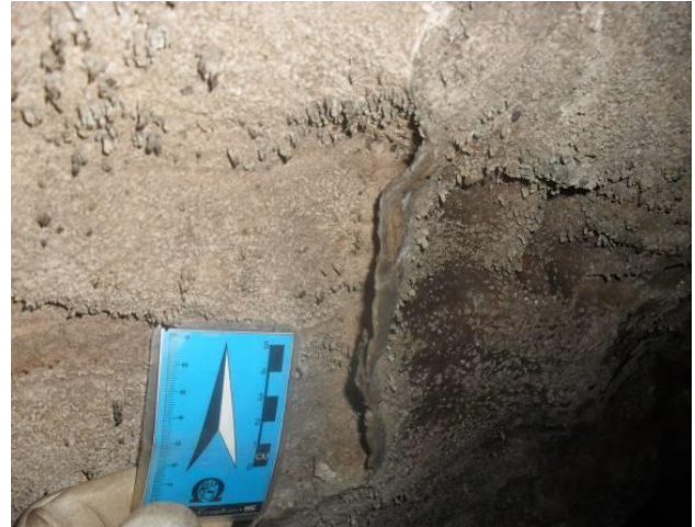
Figura 35: Cortina no conduto principal da CV 8/9/16.
