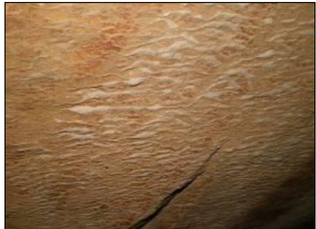
Figura 36: Microtravertinos formados por sedimentos inconsolidados na CV 01.
