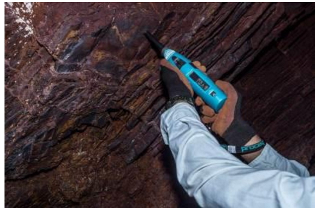
Figura 2: Exemplo de aplicação do martelo de Schmidt.
