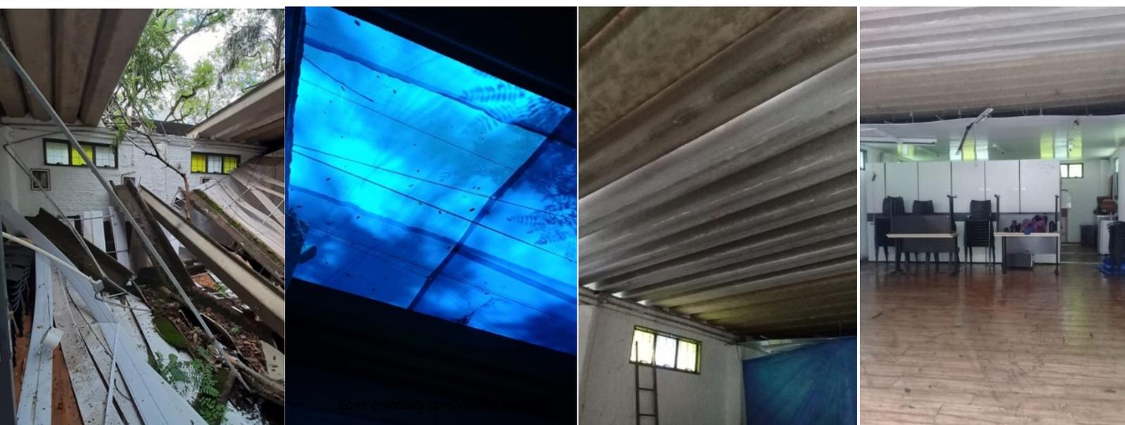
Da esquerda para a direita: Telhas quebradas pós tempestade na Sede da SBE; Lona colocada como forma paliativa; Telhas que substituíram as danificadas; Sede após a reposição das telhas
