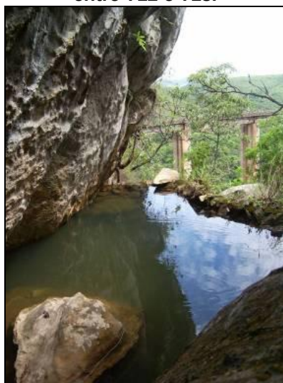
Foto 43: Detalhe do dique.
