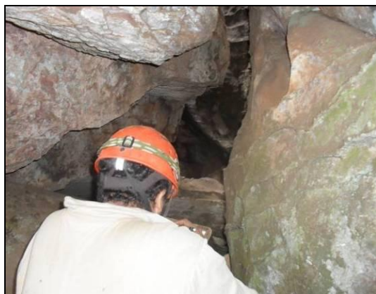
Foto 116: Interior da CV 20.
