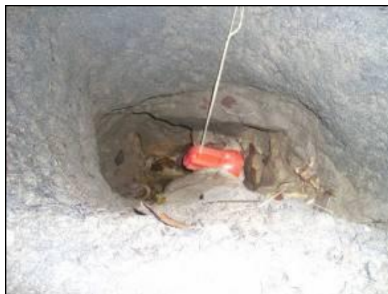
Foto 58: Detalhe do sumidouro.
