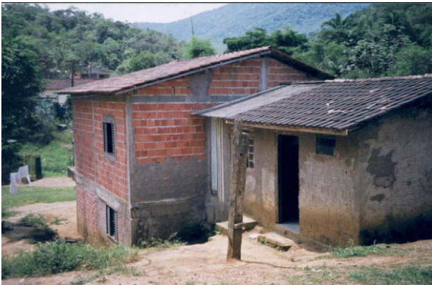
Figura 2: Casas construídas sobre o morro e mal acabadas. FONTE: Arquivo pessoal (Pesquisa de Campo, novembro, 2005)
