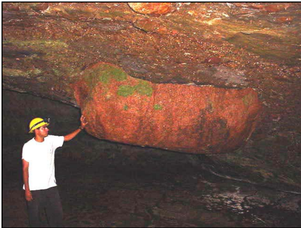
Fotografia 04 – Bloco granítico incrustado no teto da Gruta Caruana 03.
