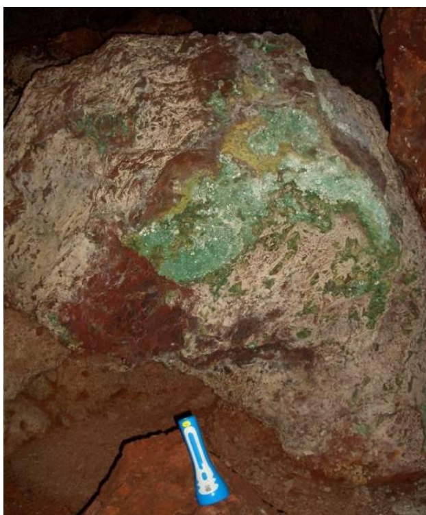
Figura 4 – Crosta branca e esverdeada revestindo bloco, no piso da cavidade em Serra Sul.
