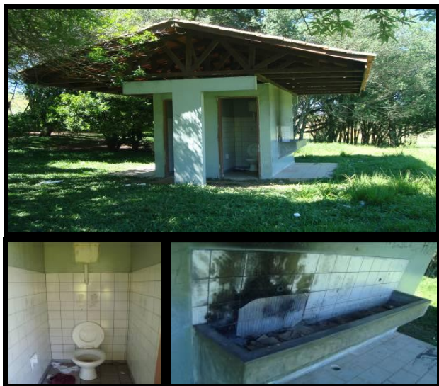
Figura 03 – Banheiro (Acervo do autor. Registro em 02.11.2010)
