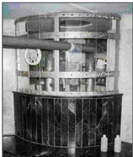
Figura 3 – O poço de Zamzam foi manualmente escavado e possui cerca de 30,5 metros de profundidade com diâmetro que varia entre 1,08 a 2,66 metros (Saudi Geological Survey, 2010).
