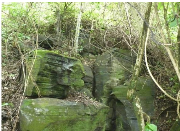
Figura 4 – Estratificação plano-paralela e fraturas sub-verticais presentes em afloramento.
