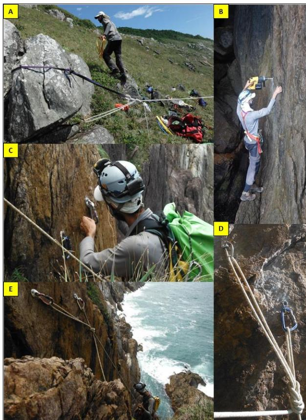
**Figura 4:** Metodologia utilizada no referido trabalho de campo à Toca da Baleia. (A) Ancoragem natural com fitas; (B) Perfuração da rocha para instalação de *spits*; (C) Instalação de chapeletas; (D) Ancoragem montada; (E) Espeleólogo em atividade após a fixação das chapeletas e cordas (Fotos de Marinês da Silva, 2017).
