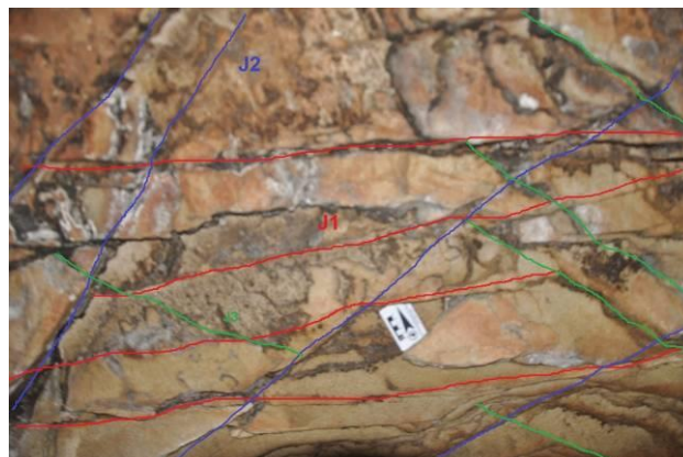
Figura 12: Estruturas J1, J2 e J3 observadas do teto da Gruta dos Viajantes.
