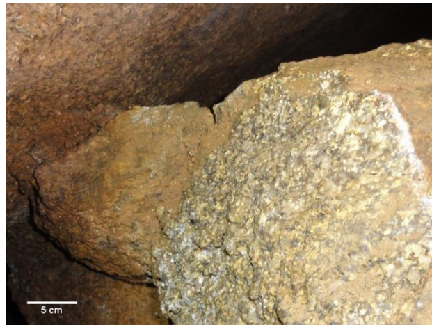
Figura 04: Elevado grau de alteração nos blocos do assoalho da cavidade, próximos ao curso de água, indicando possível variação no nível/volume d'água (Foto: D.G.V.Parizoto, 2017).
