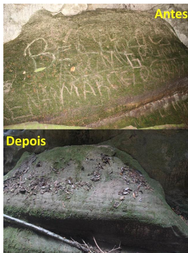
Figura 4: resultados do trabalho de recuperaç o de paredes degradadas com inscriç es.
