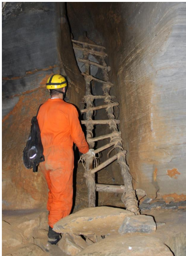
Figura 4: escadas rústicas de madeira roliça amarrada com cipós (originais de Carlos Prates)
