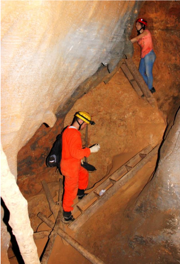
Figura 3: estrutura de andaimes e escadas em madeira serrada
