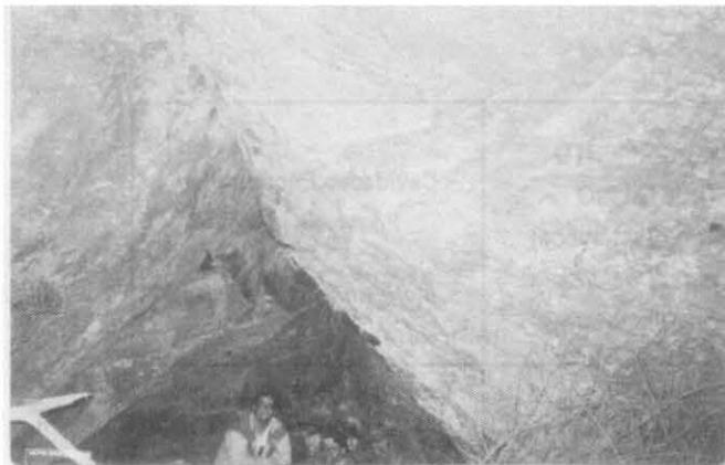
Figura 6: Falha principal controlando o conduto principal da Toca do ninho, ângulo de visada de SW NE.
