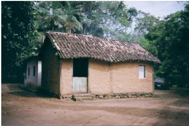
Figura 4: Casa mais antiga do bairro que hoje só é utilizada como casa do fogão a lenha e seus proprietários moram em casa de alvenaria nos fundos. FONTE: Arquivo Pessoal (Pesquisa de Campo, novembro, 2005)
