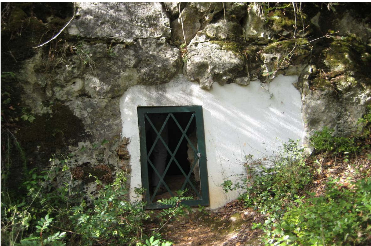
Figura 7: Vista da entrada da Lapa de Tomar (Foto: Carlos Ferreira)
