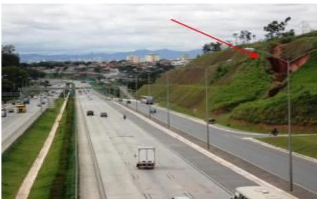
**Figura 5** – Formação de voçoroca na MG-010. Fonte: BRITO, 2012.
