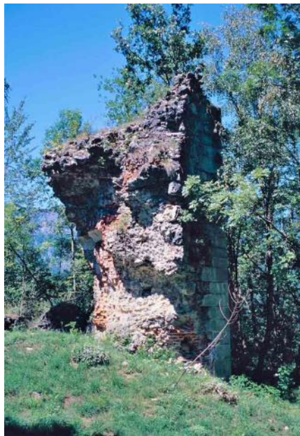
Fig. 67 - Resti della Chiesa di San Carlo.
