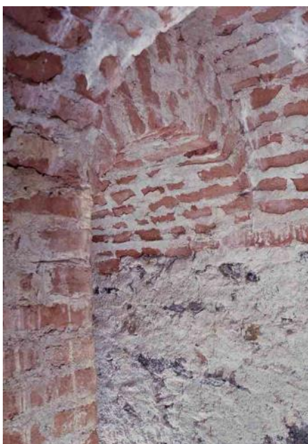
Fig. 34 - Ramo destro di contromina, anch'esso perfettamente integro.
