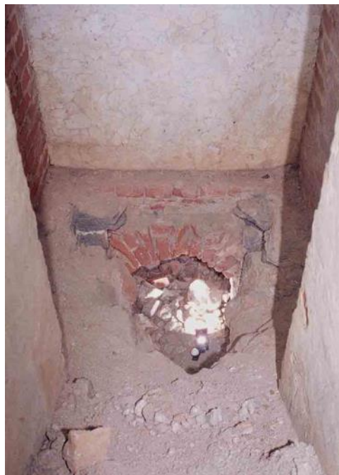
Fig. 37 - Cunicolo di Contromina: dettaglio del pavimento con pozzetto comunicante con il Cunicolo di Deflusso.
