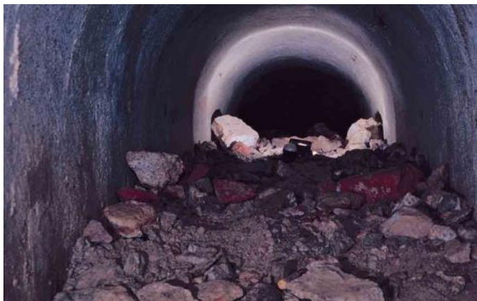
Fig. 31. Cunicolo di Contromina: quasi completamente colmo di detriti, ma perfettamente integro; difatti i fornelli scavati nei pressi dell'accesso non sono stati fatti brillare.
