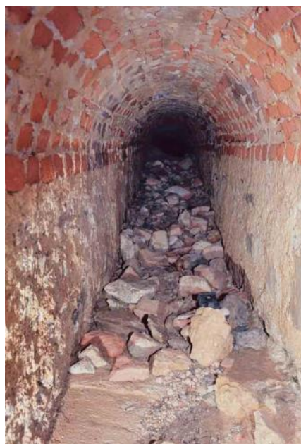
Fig. 41 - Ramo est del Cunicolo di Deflusso del Bastione di Sant'Ignazio (CA 00003 PI CN).
