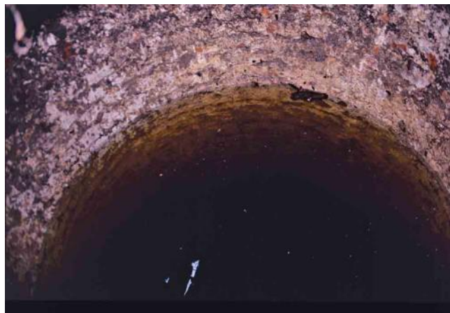
Fig. 51 - Dettaglio della parte interna perfettamente integra della cisterna.
