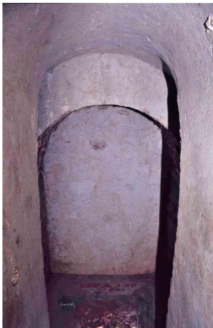
Fig. 36 - Cunicolo di Contromina: sul fondo, a pavimento, si apre il pozzetto, un tempo dotato di saracinesca verosimilmente metallica, per tenere sotto controllo il sottostante Cunicolo di Deflusso.
