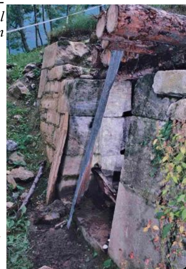
Fig. 63 - Accesso alla cisterna in parte scavata nella roccia.
