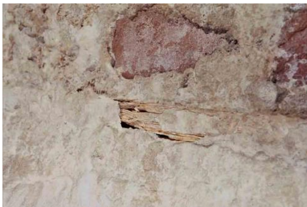
Fig. 45 - I resti di una centina lignea inglobati nella volta del Cunicolo di Deflusso.
