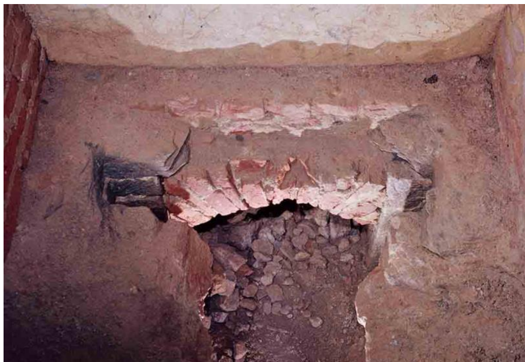
Fig. 38 - L'impianto sotterraneo è stato, anche in questo caso, scavato nella viva roccia e poi rivestito in muratura, come testimonia l'immagine. Si noti il fondo della contromina in mattoni, che separa la struttura dalla sottostante opera idraulica di deflusso, e le guide di pietra per fare scorrere la saracinesca. Il tutto era congegnato per bloccare qualsiasi ingressione avversaria nel sistema sotterraneo e rappresenta ad oggi un piccolo capolavoro di architettura militare: tali sistemi erano certamente stati realizzati anche in altre piazze-forti, come ad esempio nel Forte San Vittorio a Tortona, ma questo di Demonte è oggi perfettamente integro, studiabile e recuperabile.
