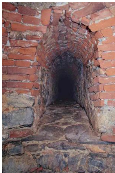
Fig. 46 - Sbocco del Cunicolo di Deflusso nella vasca circolare di sedimentazione da cui si staccano i tre condotti.
