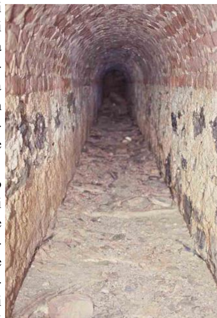
Fig. 42 - Ramo ovest del Cunicolo di Deflusso del Bastione di Sant'Ignazio (CA 00003 PI CN).
