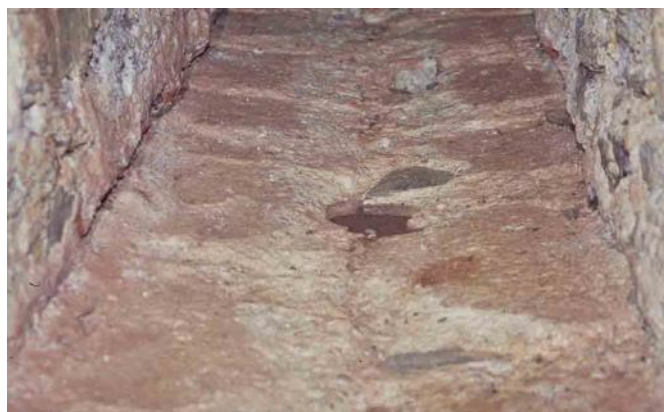
Fig. 43 - Dettaglio del fondo in muratura del Cunicolo di Deflusso.
