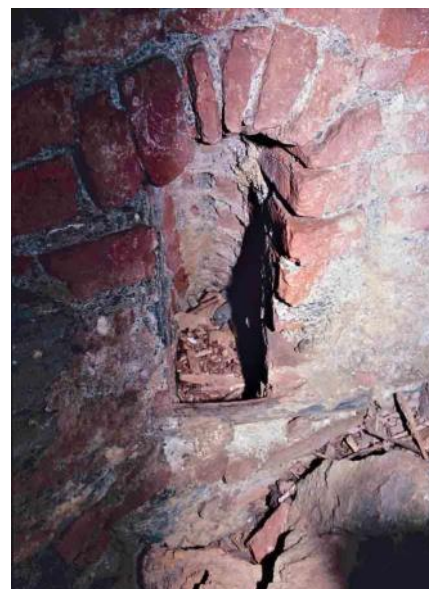
Fig. 47 - Imbocco di uno dei due condotti rimasti integri, che si stacca dalla vasca circolare di sedimentazione.
