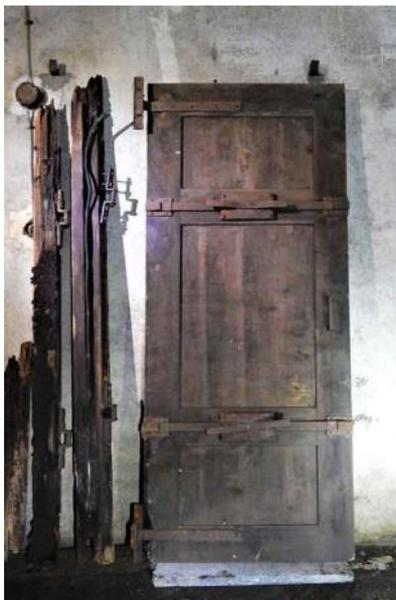
**Fig. 64.** Inusuale porta "antigas" in legno del rifugio antiaereo della Centrale di pompaggio Ascanio Sforza.
