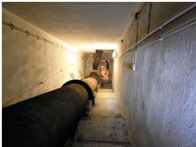
Fig. 95. Tubatura proveniente dal pozzo radiale, in disuso.
