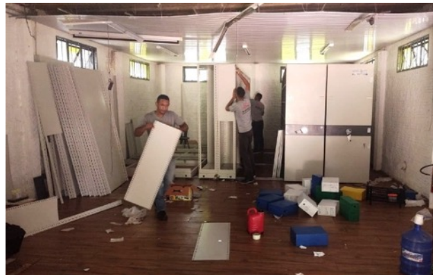
Foto 7: Última Etapa da grande operação: Equipe do Sr. Eliseu desmontando os armários no dia seguinte. Foto: Diego Ferreira.
