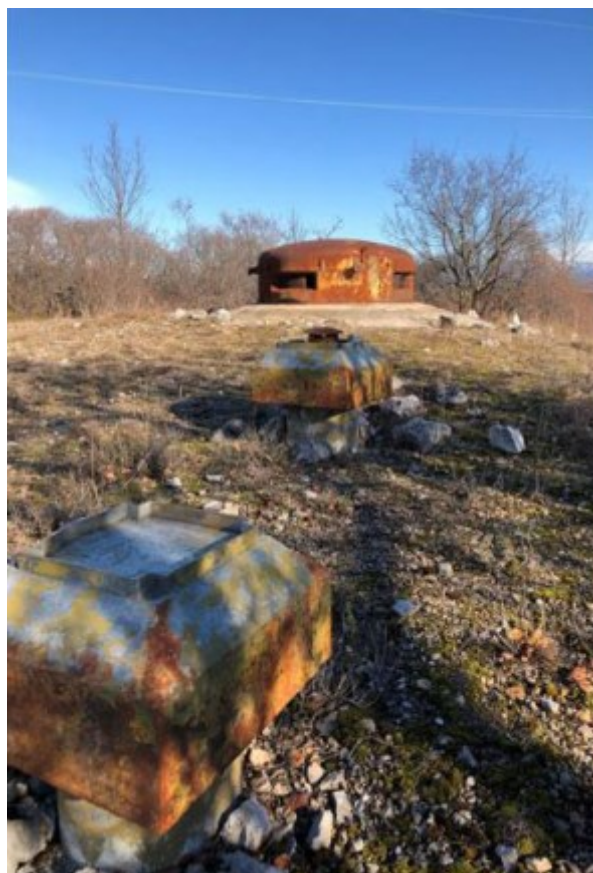
Fig. 4 - Postazione M del Blocco Nord dell'opera. In primo piano si possono osservare le prese d'aria delle sottostanti gallerie.
