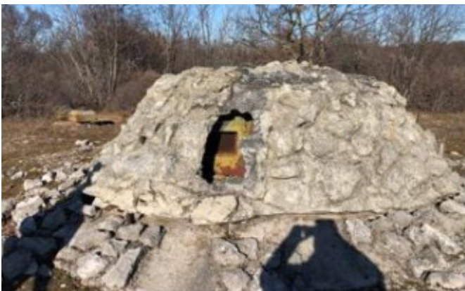
Foto 7. Postazione M con copertura, della torretta in acciaio, in vetroresina – Blocco Sud dell'opera
