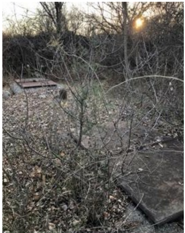
Foto 6. Ingresso Ricovero (chiuso con piastre d'acciaio) – Blocco Nord dell'opera
