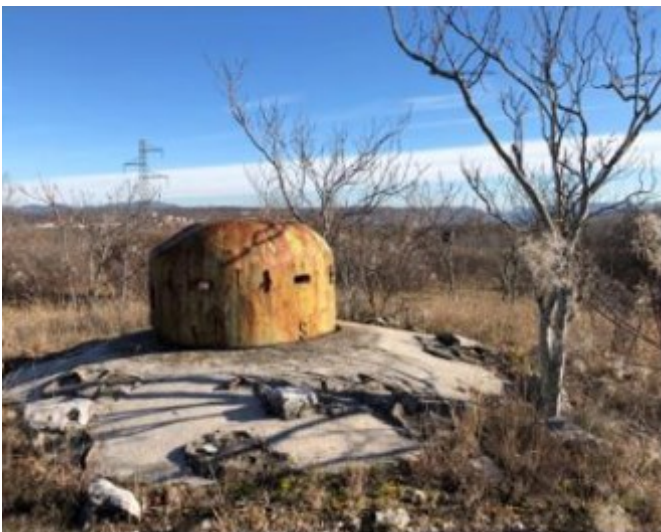
Foto 5. Torretta in acciaio per osservazione del PCO – Blocco Nord dell'opera
