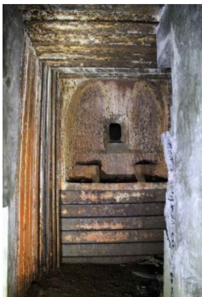
Fig. 6.55 - Scudo di un malloppo italiano degli Anni Trenta, facente parte del Vallo Alpino, visto dall'interno.
