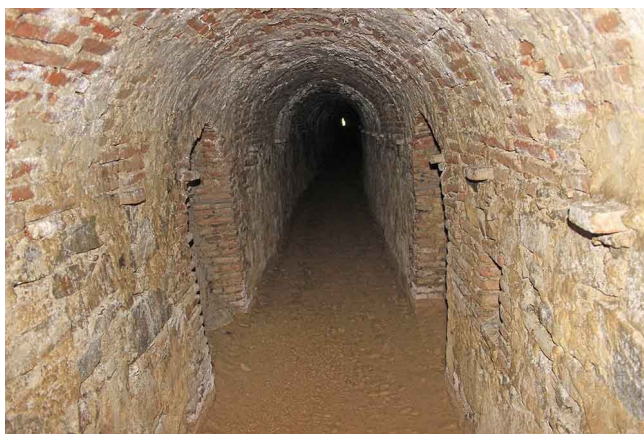
Fig. 6.80 - Palmanova: le gallerie napoleoniche sono generalmente di dimensioni piuttosto anguste e con la volta a botte; spesso presentano delle aperture laterali a fondo cieco o danno l'accesso ai fornelli di mina (Archivio M. Tavagnutti).
