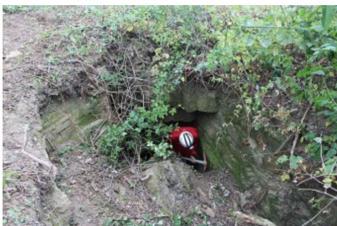
Fig. 6.101 - Monte Calvario (Gorizia). Durante dei recenti lavori sulla sommità del monte è venuto alla luce l'ingresso di una vasta e complessa galleria interamente scavata nel Flysch. L'inconsistenza della roccia flyschoida ha determinato molti crolli all'interno della cavità rendendola piuttosto pericolosa. All'interno non si notano tracce di "blindatura", ma vi sono resti di semplici opere in muratura. Inoltre nelle vicinanze esistono i ruderi di una chiesa medievale che potrebbero far pensare ad un possibile collegamento ipogeo. Su questo monte, posto di fronte alla città di Gorizia, durante la guerra 1915-18 si svolsero aspri combattimenti e pesanti bombardamenti, tanto da fare pensare che le eventuali "gallerie di guerra" dovevano, a rigor di logica, essere "blindate". Comunque non si può sottacere un dato di fatto: la cinquantina di batterie corazzate italiane costruite tra la fine dell'Ottocento e i primi anni del secolo successivo erano sovente in calcestruzzo non armato: delle vere "trappole". Lo stato Maggiore lo sapeva e, con l'entrata in guerra del Regno d'Italia, la più parte delle artiglierie vennero spostate all'esterno, in barbetta, e mascherate (Archivio M. Tavagnutti).
