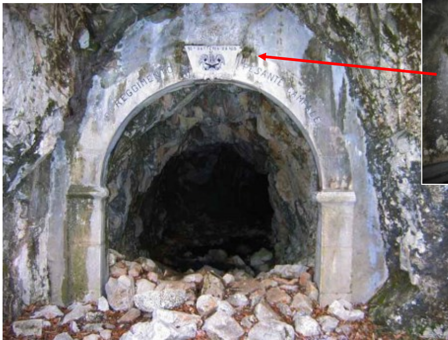
Fig. 6.43 - Monte Sabotino (San Mauro - Gorizia). Guerra 1915-18: il portale monumentale di questa "galleria cannoniera" o "batteria in caverna", denominata "Galleria presso il 3° tornante" (SA42), risale al periodo compreso il 1916 e il 1917. La cavità è stata interamente realizzata dal Regio Esercito Italiano per mettere in batteria i cannoni di medio calibro che dal Sabotino sparavano verso est (Monte San Marco, oggi in Slovenia). Il reparto che la realizzò e che vi era alloggiato apparteneva al 2° Reggimento Artiglieria Pesante Campale e si trattava della "18a batteria cannoni da 105 mm". La precisione con cui si può affermare ciò è dovuta alla presenza di un'iscrizione ben conservata, la quale sovrasta l'ingresso della cavità (Archivio M. Tavagnutti).
