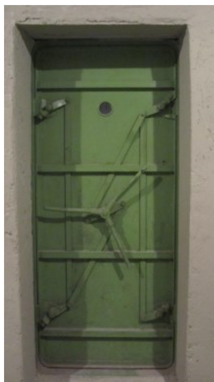
Fig. 6.144 - Una delle porte a tenuta stagna della Ditta Bergomi ancora visibile nel rifugio antiaereo della Croce Rossa di Como.
