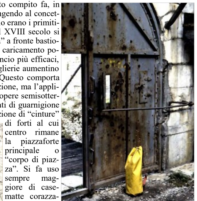
Fig. 6.17 - Uno dei portoni blindati d'accesso al Fort Écluse nel 1985, protetto da un fossato profondo circa quindici metri, scavato nella viva roccia. Quest'opera si può considerare come l'antesignana della staticamente complessa e inutile "Linea Maginot".
