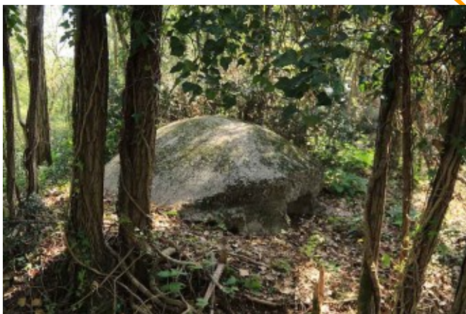
Fig. 6.32 - Colle della Pubrida (Lucinico - Gorizia). Cupola in cemento armato, con feritoie laterali, a coprire un bunker sottostante probabilmente risalente alla Prima Guerra Mondiale; potrebbe poi essere stato riadattato nel periodo della Seconda Guerra Mondiale e forse impiegato durante la "Guerra Fredda", ma ciò non è sicuro (Archivio M. Tavagnutti).
