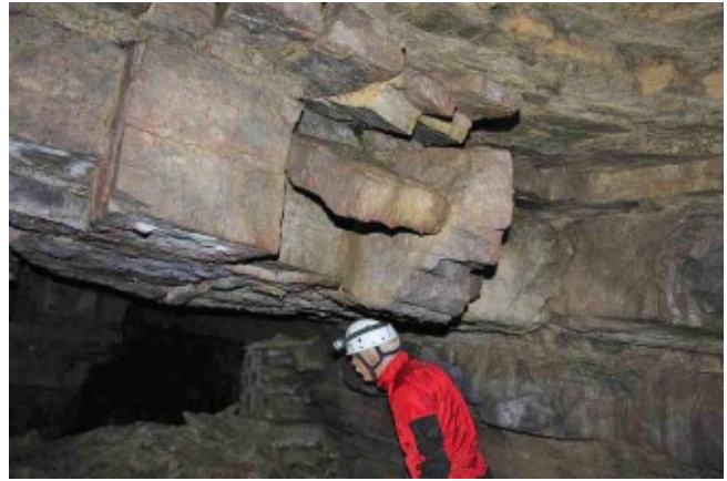
Fig. 6.104 - Monte Calvario (Gorizia). Un tratto della galleria rinvenuta durante i recenti lavori sulla sommità del monte. L'opera, come si vede, è molto instabile e pericolosa essendo interamente scavata nel Flysch (Archivio M. Tavagnutti).
