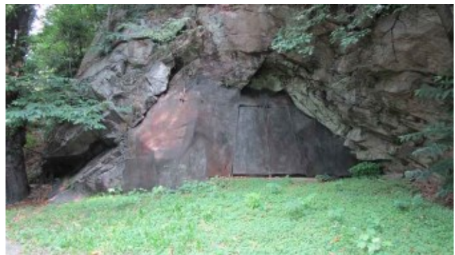
Fig. 6.72 - Mascheramento esterno rimovibile della feritoia del cannone svizzero da 105 mm.
