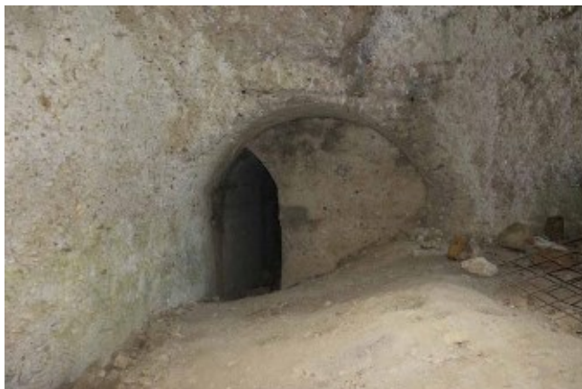
Fig. 6.122 - Guerra 1915-18. Particolare dell'interno della Galleria cannoniera del Monte Fortin presso Farra d'Isonzo (Gorizia). La galleria fu costruita interamente dal Regio Esercito Italiano per contrastare il fronte austro-ungarico del Monte San Michele sul Carso (Archivio M. Tavagnutti).
