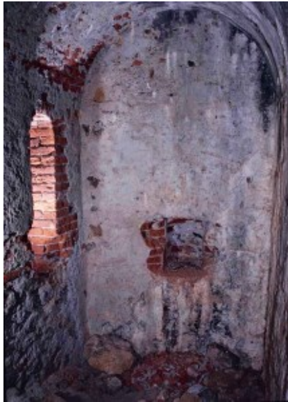
Fig. 6.107 - Forte Demonte (Cuneo): galleria di controscarpa antistante il Bastione di Sant’Ignazio. Il grande impianto difensivo, quasi interamente scavato nella viva roccia e poi rivestito in muratura, è stato documentato anche nello “Speciale” del mese di agosto 2021 del Centro Ricerche Carsiche “C. Seppenhofer” aps – Gorizia: “Forte Demonte in Valle Stura (Piemonte)”.
