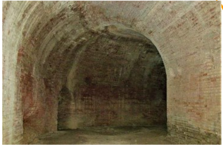
Fig. 6.113 - Cittadella di Alessandria: galleria di demolizione del Bastione di San Carlo; lungo il lato esterno si nota l'accesso al ramo di mina dove veniva alloggiata la carica esplosiva (foto Arch. S.C.A.M.).
