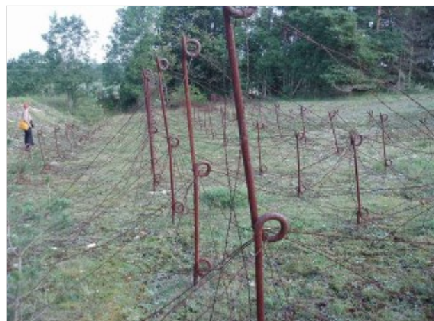
Fig. 6.62 - Esempio di largo e poco profondo fossato con sistema a reticolato di filo di ferro spinato, per sbarrare l'accesso alla fanteria, realizzato a difesa di un fianco del forte di Tingstäde (1903), situato sull'isola di Gotland (Svezia). La persona alla sinistra dello sbarramento aiuta a comprendere le dimensioni dell'impianto.
