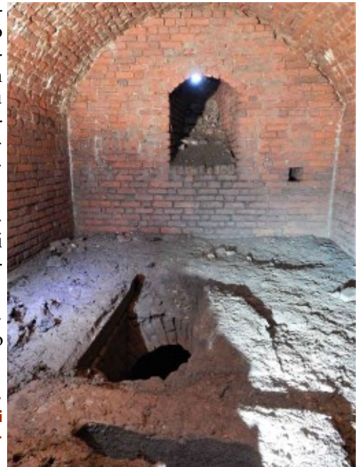
Fig. 6.48 - Castello di Porta Giovia a Milano: sotterranei quattrocenteschi ad oggi non visitabili. Vedere utilmente lo “Speciale” del mese di luglio 2021 del Centro Ricerche Carsiche “C. Seppenhofer” aps – Gorizia: “Sopra e sotto... il Castello di Leonardo”.
