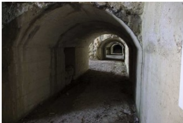
Fig. 6.123 - Guerra 1915-18. Veduta dell'asse longitudinale principale della "Galleria cannoniera del Monte Fortin" presso Farra d'Isonzo (Gorizia). La struttura dell'intera galleria era in calcestruzzo in quanto la natura geologica del Monte Fortin, costituita dal Flysch, era estremamente friabile. Le varie bocce di fuoco posizionate ortogonalmente a questa galleria erano orientate verso il Monte San Michele sul Carso (Archivio M. Tavagnutti).
