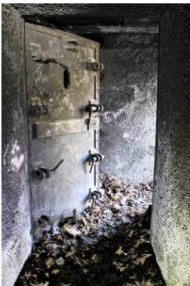
Fig. 6.52 - Porta blindata vista dall'interno del blocco facente parte della così detta "Linea Maginot delle Alpi".
