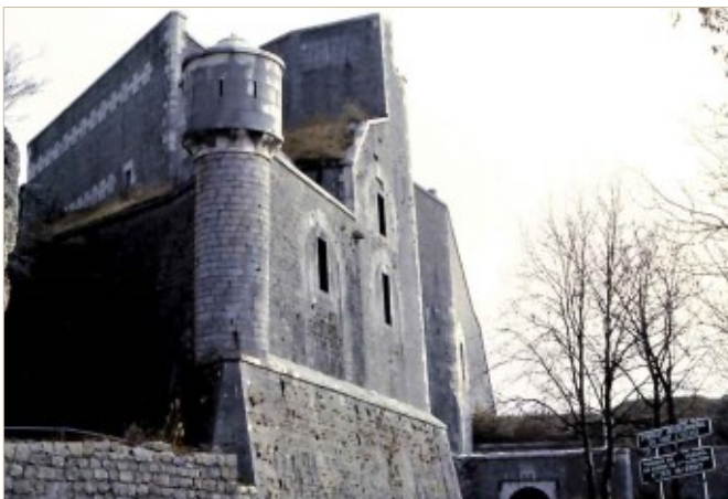
Fig. 6.16 - Fort Écluse in Francia (Dipartimento dell'Ain) nel 1985. La sua fase ricostruttiva viene effettuata tra i primi del XIX secolo e il 1885 circa, impiegando galeotti; la parte più importante è costituita dallo scavo all'interno della montagna di una quindicina di piani con camerate, magazzini, cucine, ospedale, a servizio di batterie per artiglierie poste in casamatta e in barbetta.
