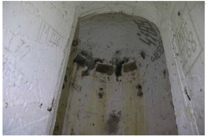
Fig. 6.37 - L'interno della cupola in cemento: non ci sono tracce di eventuali installazioni fisse per armamenti (Archivio M. Tavagnutti).
