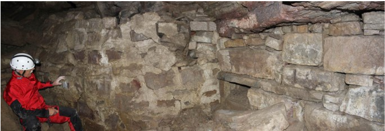
Fig. 6.105 - Monte Calvario (Gorizia). Il muro ritrovato all'interno della galleria è costituito da pietre squadrate unite da malta, in corsi non sempre regolari. Questo fa pensare ad una costruzione antecedente la Prima Guerra Mondiale e probabilmente legata alla presenza della vicina chiesa medievale (Archivio M. Tavagnutti).
