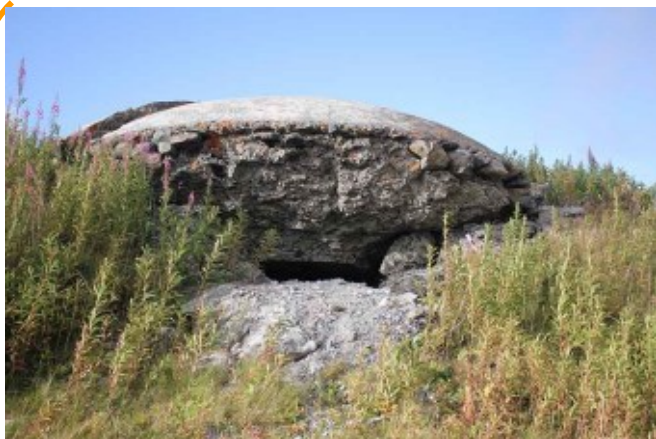
Fig. 6.31 - Cupola in calcestruzzo non armato di un'opera del Vallo Alpino al Passo del Piccolo San Bernardo.
