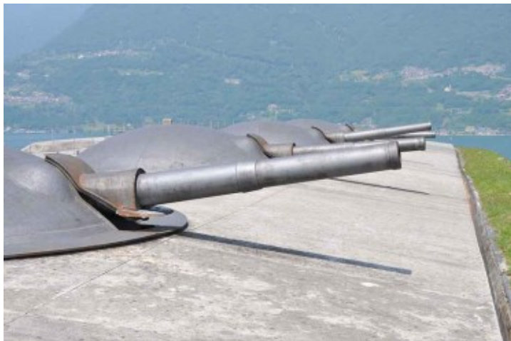
Fig. 6.65 - Cupole girevoli del Forte Montecchio Nord (Lecco), armate con cannoni 149/35 Schneider in perfetto stato di conservazione. L'opera sbarrava l'Alto Lario, chiudendo la cosiddetta "porta della Valtellina".
