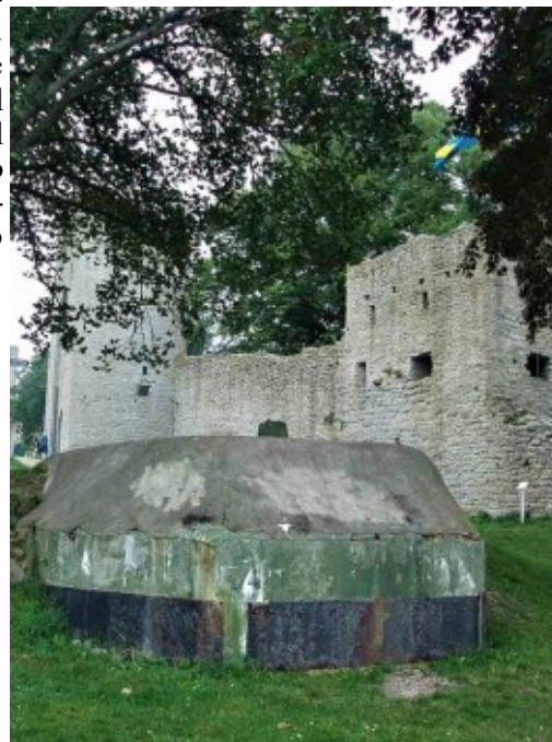
Fig. 6.10 - Casamatta (o bunker) con le feritoie chiuse da pannelli metallici a difesa del litorale antistante la città di Visby (Svezia). Alle spalle dell'opera si scorge la cinta d'epoca medievale con una delle porte-torri protetta dal duplice fossato.
