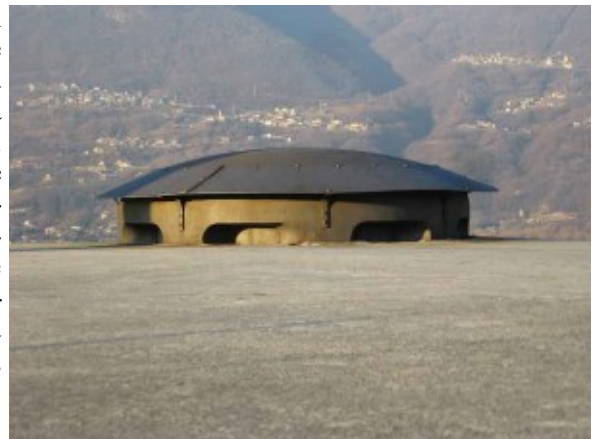
Fig. 6.60 - Osservatorio blindato a scomparsa, a torretta o cupola, del Forte Montecchio Nord (Lecco); è situato all'estremità ovest della batteria corazzata.
