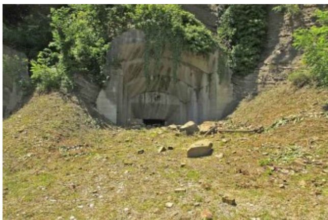
Fig. 6.125 - Veduta esterna di una casamatta della "Galleria cannoniera del Monte Fortin" parzialmente ostruita dagli sfasciumi della roccia flyschoida, i cui strati si possono vedere sulla destra della foto (Archivio M. Tavagnutti).
