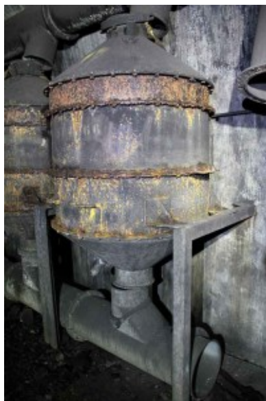
Fig. 6.53 - Dettaglio di uno dei filtri dell'impianto di depurazione del precedente blocco francese.
