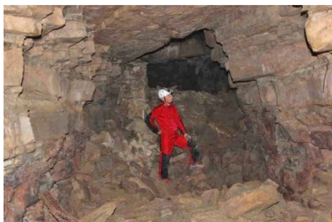
Fig. 6.102. Monte Calvario (Gorizia). Un tratto della galleria rinvenuta durante i recenti lavori sulla sommità del monte. Come si vede la galleria è instabile ed è interamente scavata nel Flysch. Alle spalle dello speleologo si intravede una parte del muro costruito con pietre e malta (Archivio M. Tavagnutti).
