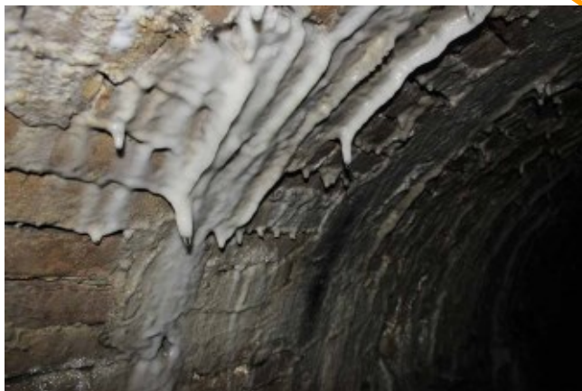
Fig. 6.78 - Palmanova: l'acqua di percolamento lungo il rivestimento di mattoni delle gallerie in alcuni punti dà origine ad un consistente concrezionamento (Archivio M. Tavagnutti).
