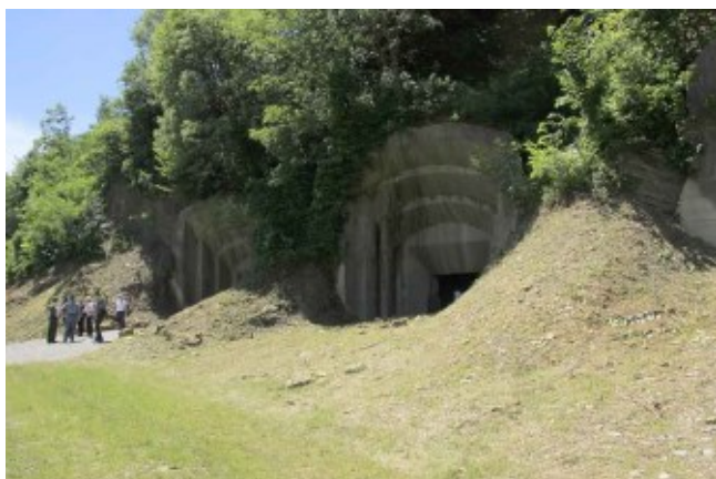
Fig. 6.124 - Veduta esterna di due bocche di casematte della "Galleria cannoniera del Monte Fortin". Le aperture, che sono state recentemente ripulite, appaiono ancora integre. Accanto ad esse si possono notare gli sfasciumi della roccia flyschoida estremamente degradabile (Archivio M. Tavagnutti).
