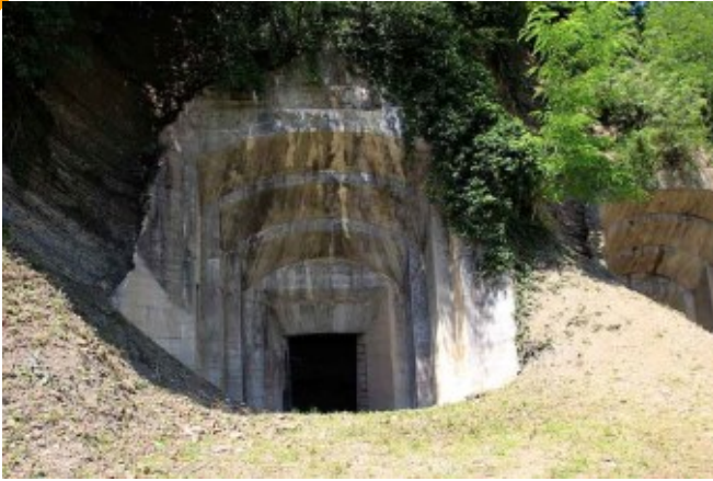
Fig. 6.126 - Veduta esterna di una delle tre casematte ancora integre della "Galleria cannoniera del Monte Fortin"; si può notare la struttura in cemento a gradoni che aveva la funzione di paraschegge contro eventuali bombardamenti (Archivio M. Tavagnutti).
