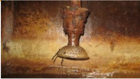
Fig. 6.69 - Filtro dell'impianto di prelievo dell'acqua da una delle cisterne del Forte Montecchio Nord.
