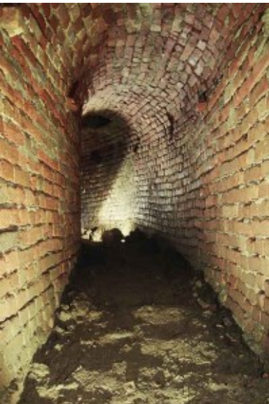
Fig. 6.86 - Galleria di collegamento scavata nell'arenaria e internamente rivestita in mattoni, ancora esistente presso il Forte di Verrua (Torino), nonostante l'azione demolitrice della cava. Con ogni probabilità consentiva il collegamento protetto tra la Porta del Soccorso (rivolta verso il fiume Po) e gli ordini di bastioni che difendono i fianchi sud est, sud e sud ovest, ovvero quelli predestinati ad essere investiti in caso di assedio. La fortezza è stata indagata dall'Ass.ne S.C.A.M negli Anni Novanta del XX sec. e i risultati sono stati pubblicati anche in Inghilterra.
