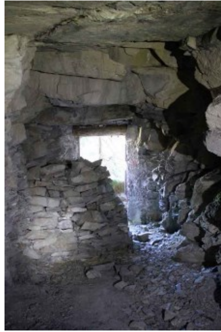
Fig. 6.147 - Rifugio o ricovero francese per fanteria, scavato negli Anni Venti del XX secolo in un fianco roccioso prossimo al confine italiano. Si noti il cumulo di pietrame eretto a ridosso dell'accesso con funzione paraschegge e parasoffio.
