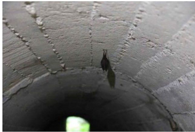
Fig. 6.38 - Sul soffitto di una galleria ha trovato rifugio un pipistrello. Si può notare la rifinitura molto grezza della galleria, il che fa pensare ad una costruzione antecedente la "Guerra Fredda" (Archivio M. Tavagnutti).
