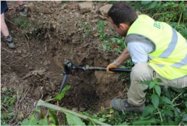
Fig. 6.103 - Monte Calvario (Gorizia). Durante i recenti lavori sulla sommità del monte, gli artigiani hanno dovuto eseguire un duro lavoro per bonificare dagli ordigni bellici l'area dove è venuto alla luce l'ingresso della nuova galleria (Archivio M. Tavagnutti).
