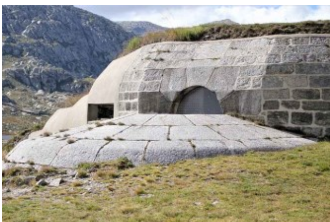
Fig. 6.73 - Svizzera, Campo Trincerato del San Gottardo: opere del XIX secolo integrate da fortificazioni del XX secolo.
