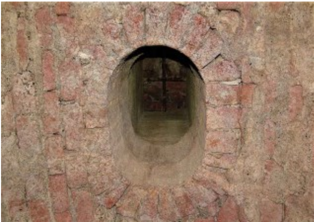
Fig. 6.114 - Cittadella di Alessandria: pozzo ricavato nella volta del ramo di mina della galleria di demolizione del Bastione San Carlo; era funzionale al sistema di più rami di mina per il "rovesciamento" dei due lati costituenti il saliente del bastione nel fossato asciutto, antistante il bastione stesso (foto Arch. S.C.A.M.).
