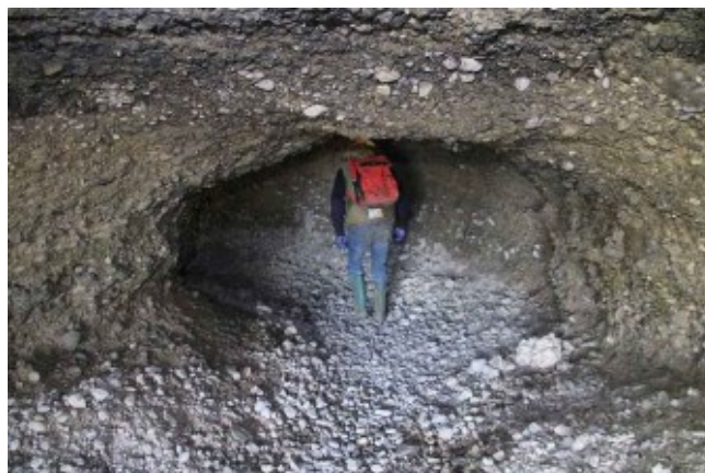
Fig. 6.98. Interno di una galleria scavata nel conglomerato presente sulla sponda sinistra dell'Isonzo. Nella foto si può vedere chiaramente come la matrice abbia consistenza davvero precaria (Archivio M. Tavagnutti).
