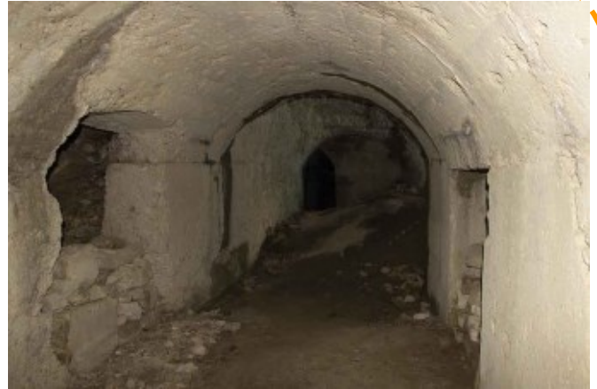
Fig. 6.127 - Guerra 1915-18. "Galleria cannoniera del Monte Fortin", la cui struttura interna era rivestita in calcestruzzo. Lateralmente si aprono le gallerie secondarie che in alcuni casi non sono completamente rinforzate e lasciano intravedere la retrostante roccia flyschoida, assai degradata e in alcuni punti collassata (Archivio M. Tavagnutti).
