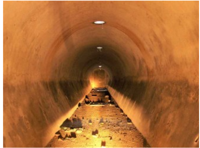
Fig. 6.139 - Ricovero antiaereo di tipo tubolare, costituito da due tronconi di galleria e da almeno tre accessi, per uno sviluppo complessivo di una cinquantina di metri. Non offriva grandi garanzie di sicurezza in quanto la volta aveva uno spessore di circa 30 cm, ricoperti con terra di riporto. Si trova nei pressi del Cimitero Monumentale di Bergamo ed era presumibilmente a servizio di alcune vicine industrie; è stato studiato e rilevato dall'Ass.ne S.C.A.M. - F.N.C.A. nel 2009.
