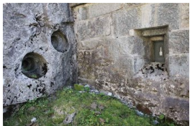
Fig. 6.74 - Svizzera, Campo Trincerato del San Gottardo: a sinistra si notano le feritoie scavate nella viva roccia della parte ottocentesca di uno dei forti.
