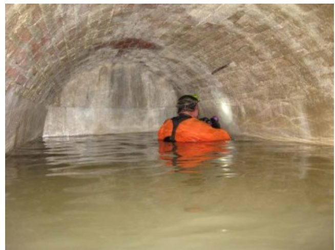
Fig. 6.111 - Indagine in una delle cisterne.
