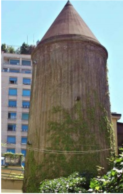
Fig. 6.146 - Torre delle Sirene: rifugio antiaereo di tipo speciale in elevato della Regia Prefettura di Milano, costruito nel 1939. Vedere utilmente lo “Speciale” del mese di maggio 2021 del Centro Ricerche Carsiche “C. Seppenhofner” aps – Gorizia: “Torre delle Sirene”.
