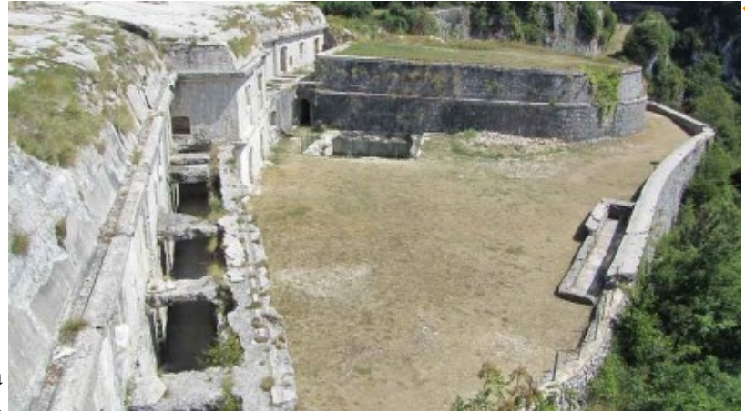
Fig. 6.70 - Fronte di gola del Forte Corbin (Forte di Punta Corbin) sull'Altopiano di Asiago; si tratta di una batteria corazzata (opera permanente) dotata in origine di n° 6 pezzi d'artiglieria da 149 mm sotto blinda girevole. Proprietà della Famiglia Panozzo, oggi è visitabile.
