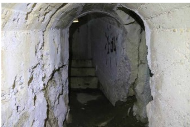
Fig. 6.35 - Colle della Pubrida (Lucinico - Gorizia). Un tratto del corridoio del bunker con la scalinata che porta alla cupola in cemento. Dal tipo di costruzione si tratta, molto probabilmente, di un'opera della Prima Guerra Mondiale e riadattata nel periodo della Seconda Guerra Mondiale (Archivio M. Tavagnutti).
