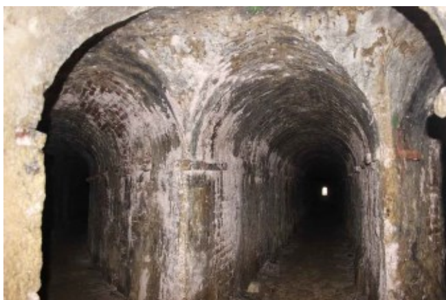
Fig. 6.81 - A Palmanova le gallerie napoleoniche seguono l'andamento dei contrafforti delle mura della città: ad ogni cambio di angolazione corrisponde un deciso cambio di direzione delle gallerie sottostanti (Archivio M. Tavagnutti).
