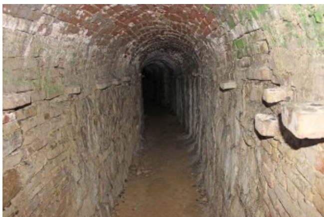
Fig. 6.79 - Le gallerie delle cosiddette lunette napoleoniche di Palmanova sono molto estese e di dimensioni piuttosto anguste, permettendo il passaggio di un solo uomo per volta. Si tratta dell'impianto difensivo sotterraneo composto da opere di collegamento, contromine e opere di demolizione (Archivio M. Tavagnutti).
