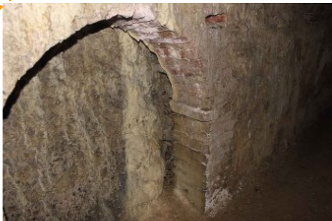
Fig. 6.77 - Le gallerie costruite nelle cosiddette lunette napoleoniche di Palmanova sono tutte rivestite di mattoni e a intervalli presentano delle aperture da cui si può vedere il terreno in cui sono state scavate (Archivio M. Tavagnutti).
