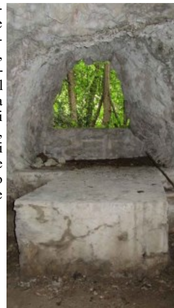
Fig. 6.119 - Postazione della "Linea Cadorna" scavata all'interno di un fianco roccioso per l'installazione di una mitragliatrice.
