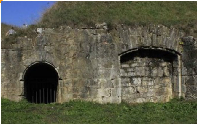
Fig. 6.83 - Accesso a un impianto sotterraneo della fortezza stellare di Palmanova (Archivio M. Tavagnutti).
