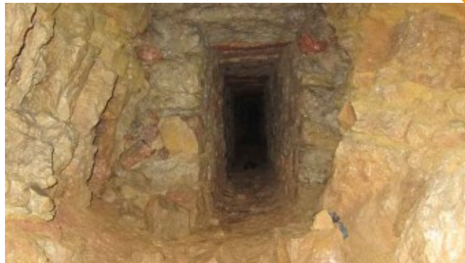
Fig. 6.5 - Uno dei rami di captazione dell'acquedotto militare del Forte di Punta Corbin.
