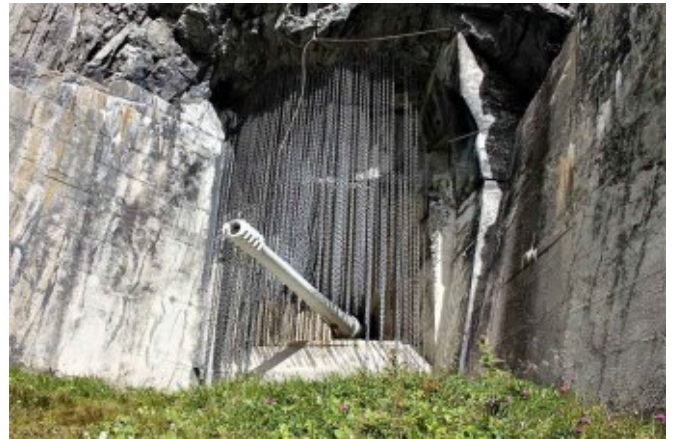
Fig. 6.129 - Forte San Gottardo (Svizzera): veduta esterna della feritoia della casamatta in cemento armato in cui è alloggiato il cannone da 150 mm.
