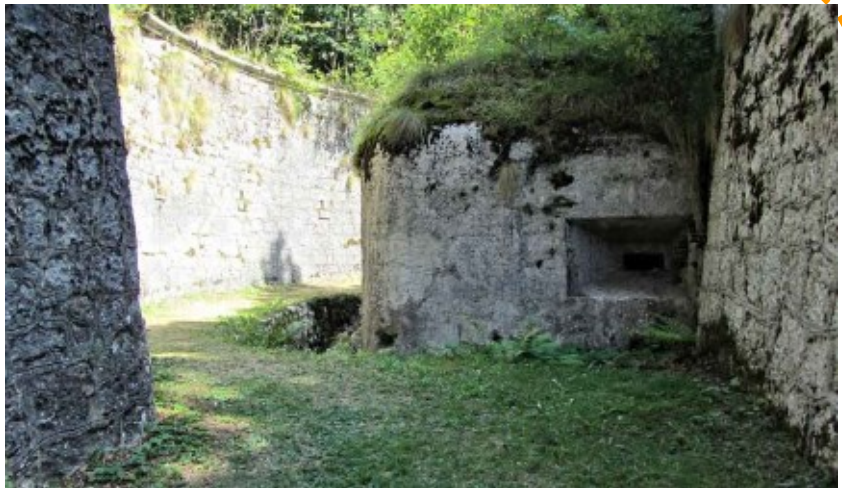
Fig. 6.50 - Altopiano di Asiago, batteria corazzata italiana denominata Forte di Punta Corbin: primo piano della capponiera che tiene sotto controllo il fossato asciutto “tagliato” nella roccia e rivestito.
