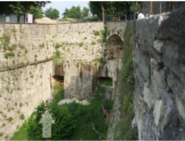
Fig. 6.41 - Bergamo, cinta bastionata veneziana: inferiormente alle feritoie delle casematte vi è la sortita del bastione (indicata dalla freccia).
