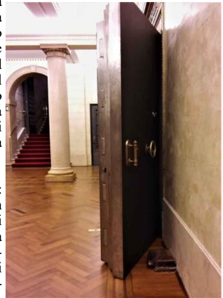
Fig. 5.34 - Si noti lo spessore della porta corazzata della Fichet; l'edificio e il caveau sono aperti al pubblico e facenti parte del circuito culturale "Gallerie d'Italia".
