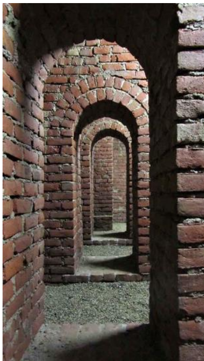
Fig. 5.30 - L'ipogeo sottostante la statua equestre è semplicemente il basamento della stessa a struttura "alveolare", ospitante anche un pozzo perdente.
