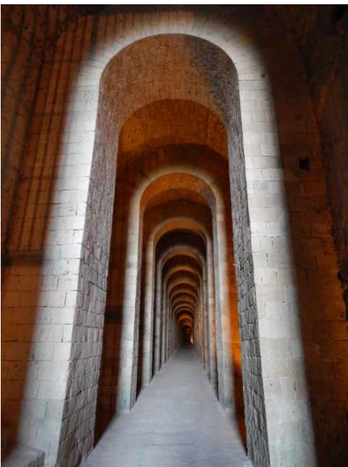
Fig. 5.20 - Napoli: Grotta di Seiano; il tunnel è lungo circa 780 metri ed è stato realizzato in epoca romana, ma rinforzato con arcate in muratura nel XIX secolo.
