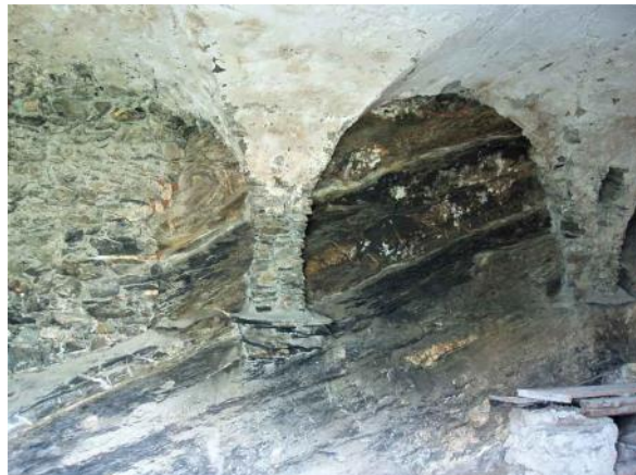
Fig. 5.5 - Palazzo Capponi a Triora (Imperia): una grande stanza destinata a cantina presenta la volta lunettata che non poggia su di una linea d'imposta, ma su pilastri che a loro volta poggiano direttamente sulla bancata calcarea a strati inclinati.
