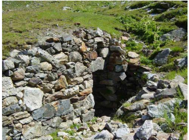
Fig. 5.3 - Accesso all'edificio sotterraneo situato in Val Pellice (Aosta); internamente la volta a botte si presenta in pietra non squadrata (foto di Claudia Ninni).
