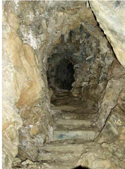
Fig. 5.9 - Il cunicolo è scavato nella roccia ed è parzialmente rivestito in pietrame con rari conci; il tratto principale è fortemente inclinato verso il basso, è lungo 15 m ed è impostato sull'asse 257°-77°. Al fondo s'incontra con un altro cunicolo che procede sull'asse 274-94, purtroppo quasi completamente ostruito da terra e materiale di risulta.
