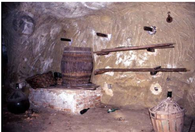
Fig. 5.4 - Cantina scavata nell'arenaria, nei pressi di Ceva (Cuneo). Alla parete sono infissi dei supporti in legno per poggiarvi delle mensole, mentre nell'angolo, riquadrato superiormente in mattoni, vi è il pozzo.
