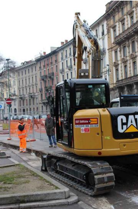
Fig. 7 - Piazza Castello: gli scavi con la ruspa per la posa delle tubature intercetta le murature della cimata Fortezza Reale. Dovrò spiegare personalmente all'archeologo che segue il cantiere dove passare per non rovinare il rivellino e il bastione (ph. G. Padovan).
