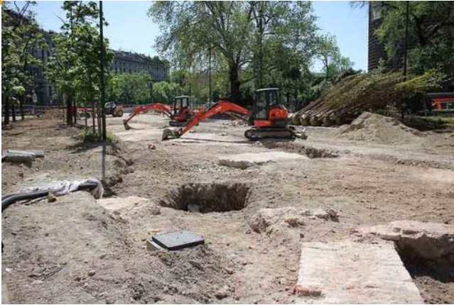
Fig. 10 - Ecco il cantiere e le fosse scavate dalle ruspe per poter piantumare: non si tratta certamente di scavi archeologici di tipo stratigrafico (ph. G. Padovan).
