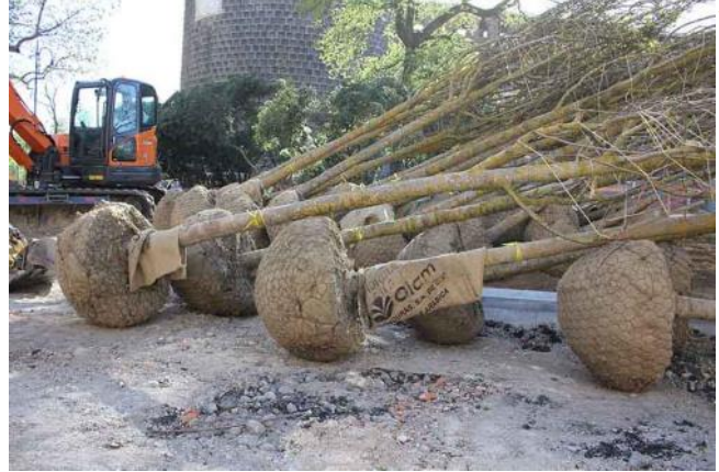
Fig. 11 - Alberi lasciati in cantiere per quattro settimane: sono stati spostati dopo le rimostranze solo venerdì 23 aprile (ph. G. Padovan).
