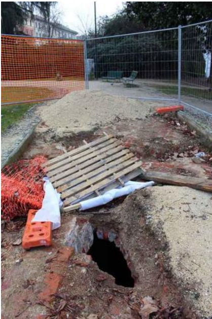
Fig. 5 - Novembre 2019: nel celebrato "anno di Leonardo" la Soprintendenza autorizza il cantiere al di sopra della Ghirlanda: ecco il risultato dello scavo con la ruspa e del successivo allargamento manuale per vedere "che cosa ci fosse sotto". Attenzione: i rilievi planimetrici del sotterraneo erano già stati pubblicati nel 1996 nel libro La fortezza celata (ph. G. Padovan).
