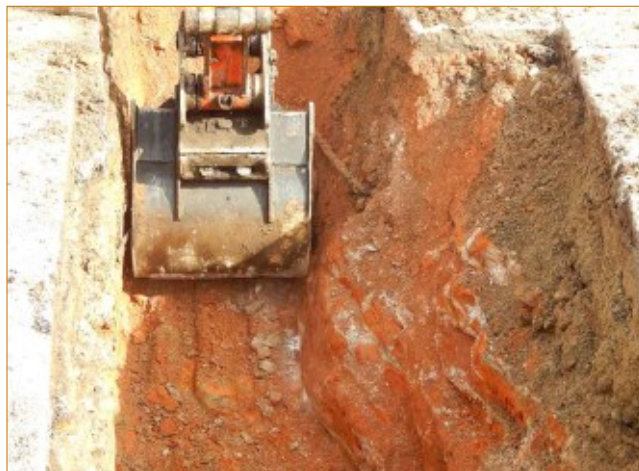
Fig. 37 - Qualcheduno ha sostenuto che le ruspe stavano scavando in un cumulo incoerente di mattoni, frutto della "cimatura" di baluardi e rivellini della Fortezza Reale, ma la foto parla chiaro: la benna sta asportando solide murature, che non vengono tutelate né dal Comune né tantomeno dalla Soprintendenza.
