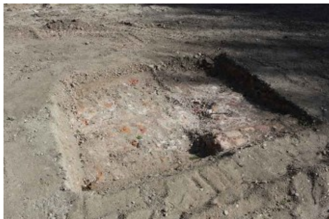
Fig. 102 - Stando al progetto vincente si sono scavate due lunghe file parallele di fosse, ma la terra non c’è e le piante non possono radicare. Se non fossimo intervenuti tempestivamente che sarebbe successo? Avrebbero forse sfondato le architetture del Cinquecento per fare spazio?
