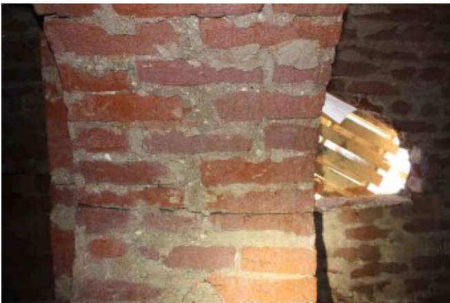
Fig. 97 - Dettaglio della volta della galleria lesionata tanto dal peso della ruspa quanto dall'azione demolitrice della sua benna.
