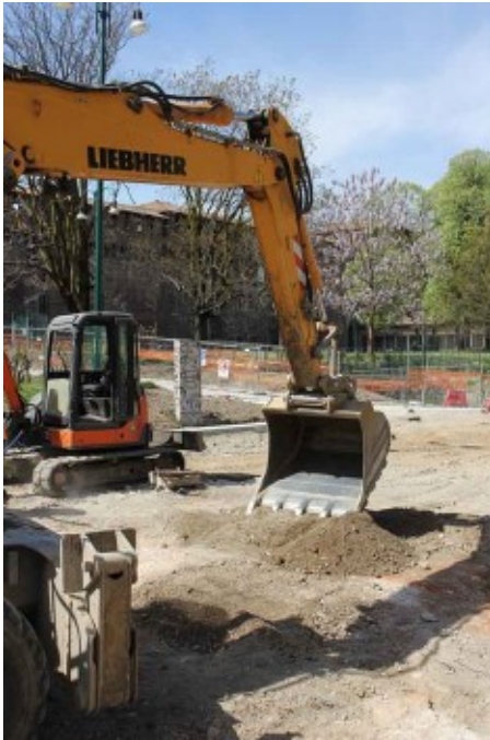
Fig. 114 - Piazza Castello, tra Via Giovanni Lanza e Via Quintino Sella: teorie di fosse disposte lungo due tracciate curvilinee parallele intercettano le opere rinascimentali. Per approfondire le fosse affinché gli alberi possano essere piantati occorrerebbe che le solide murature vengano asportate con i mezzi meccanici, ma fortunatamente le proteste hanno avuto un eco talmente potente da arrestare lo scempio. Qualcheduno ci ha detto: «Insistete, perché quello che essi temono è solamente la cattiva pubblicità».
