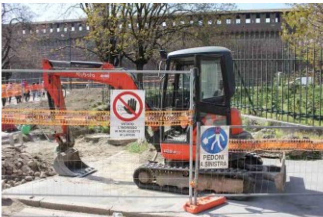
Fig. 126 - 14 aprile 2022. Lavori sulla “Strada a Esse”: si levano l’acciottolato e qualche lastra di granito per rimetterli esattamente come prima qualche giorno dopo.
