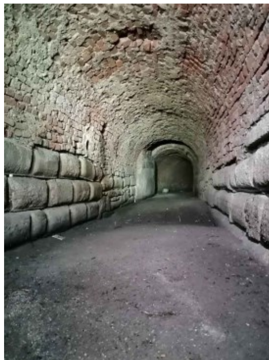
Fig. 76 - Già nel 1989 si è esplorato e studiato questo antico canale situato in Parco Sempione e realizzato, con ogni probabilità, utilizzando materiale di spoglio della vicina Opera a Tenaglia. Difatti si notino i primi corsi realizzati in conci bugnati di granito omogenei tra loro: a Milano non vi è alcunché d'eguale per forma e dimensioni: difatti i bugnati dei torrioni sforzeschi del Castello sono decisamente differenti.
