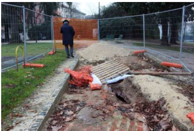
Fig. 94 - Tratto dell'estradosso della Galleria delle Radici della Ghirlanda messo in luce e sfondato anche dalla ruspa; oltre la recinzione del cantiere si intravede il rudere della Torre della Colubrina.
