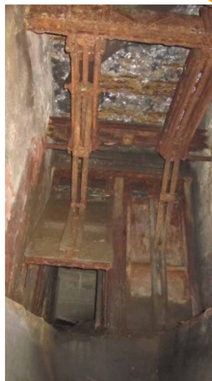
Fig. 19 - Resti di saracinesche per la regolazione dell'acqua nei canali sotterranei.
