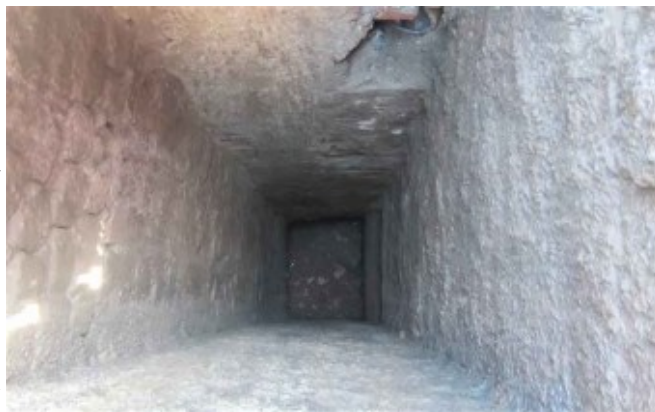
Fig. 118 - Interno del camino di areazione della casematta del Baluardo Albuquerque: il suo svuotamento avrebbe permesso di accedere agli spazi interni (casematte, polveriere, sortite, contromine e la strada in galleria che conduceva a giorno nel fronte di gola). Certamente tale Baluardo si sarebbe potuto renderlo accessibile anche alle visite pubbliche e proprio attraverso la riapertura della galleria nel fronte di gola e le sortite (foto di Roberto Basilico).
