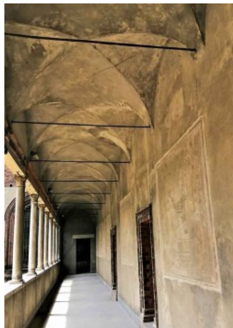
Fig. 58 - Chiusa al pubblico da decenni, la Ponticella oggi versa in precarie condizioni: vistose crepe negli intradossi delle arcate sono state semplicemente sigillate qualche anno fa con cemento (?) scuro, il tetto è da rifare e gli intonaci da soli testimoniano l'incuria e l'abbandono.
