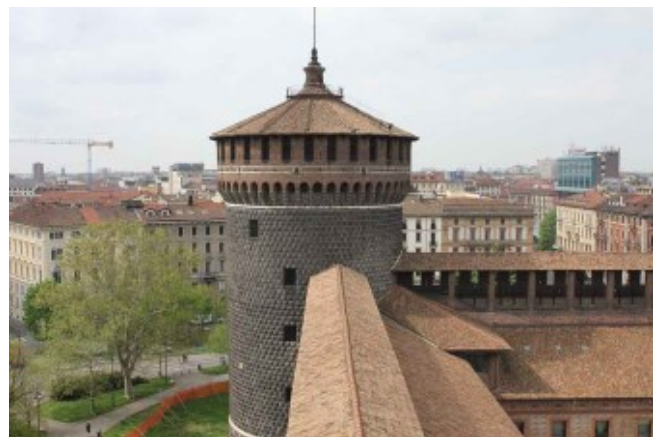
Fig. 51 - Scorcio del muro di cortina ovest con il torrione a pianta circolare, bugnato, fatto costruire da Francesco Sforza nella seconda metà del XV secolo unitamente al "gemello", ad est, che chiudeva la fronte del Castello verso la città.
