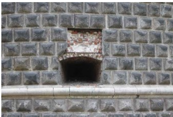
Fig. 151 - Torrione d'epoca sforzesca (seconda metà del XV secolo). Il paramento murario in conci bugnati è mancante da almeno cinquant'anni. Un elemento era all'interno della feritoia, ma poi alcuni anni fa è stato rimosso. Dov'è finito?
