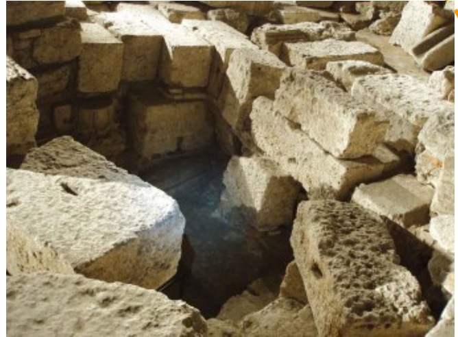
Fig. 6 - Basilica di San Lorenzo Maggiore: scorcio della platea costituita anche da frammenti architettonici d'epoca romana situata al di sotto del pavimento della Cappella di Sant'Aquilino.
