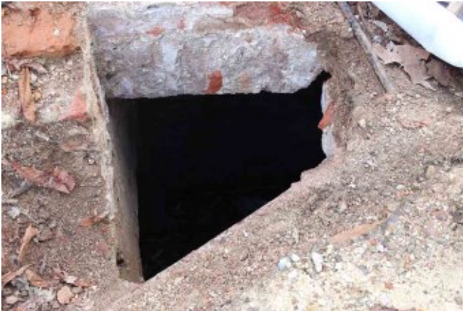
Fig. 95 - Sfondamento con la benna della ruspa e successivo allargamento manuale che va a compromettere irrimediabilmente quanto documentato da Leonardo da Vinci.
