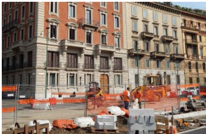
Fig. 35 - Milano 2013: Piazza Castello angolo Via Giovanni Lanza. Si scava per posare nuovi cordoli, realizzare il marciapiedi e posare tubature, ma si intercettano le bastionature della Fortezza Reale rinascimentale.
