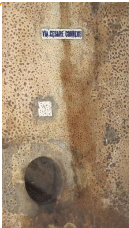
Fig. 18 - Milano Underground: molti canali sono stati riutilizzati nell'impianto fognario già nei secoli precedenti.
