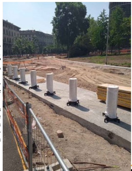
Fig. 123 - Fase intermedia dei lavori di deturpamento del Baluardo Albuquerque: installata la pesante armatura che ingabbia i "milomat".
