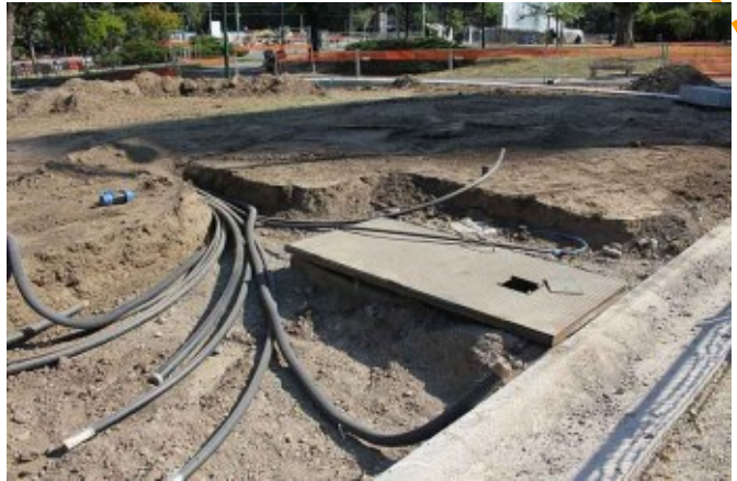
Fig. 142 - Si scava e si tombina come se sotto non vi fosse alcunché da preservare. Difatti, come dimostrato da precedenti immagini, a Milano il patrimonio architettonico, archeologico, monumentale e storico non esiste. Pertanto, perché pagare i funzionari? Se non si tutela, almeno che si ironizzi!
