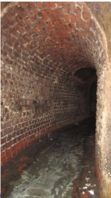
Fig. 16 - Milano Città d'acque: i canali principali della città celta e poi "romana" assolvevano al compito difensivo e servivano al traffico idroviario. Se in superficie la gran parte di essi è "scomparsa", in una certa misura li si può ancora vedere e percorrere nel sottosuolo urbano.
