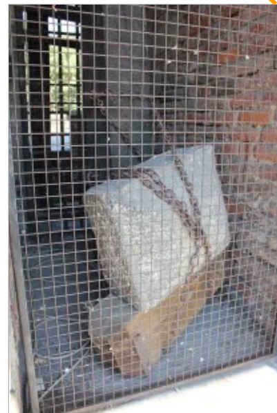
Fig. 151a - Elemento del paramento murario del torrione d'epoca sforzesca: giace nel vano come contrappeso da circa cinquant'anni. Occorre aggiungere altro?
