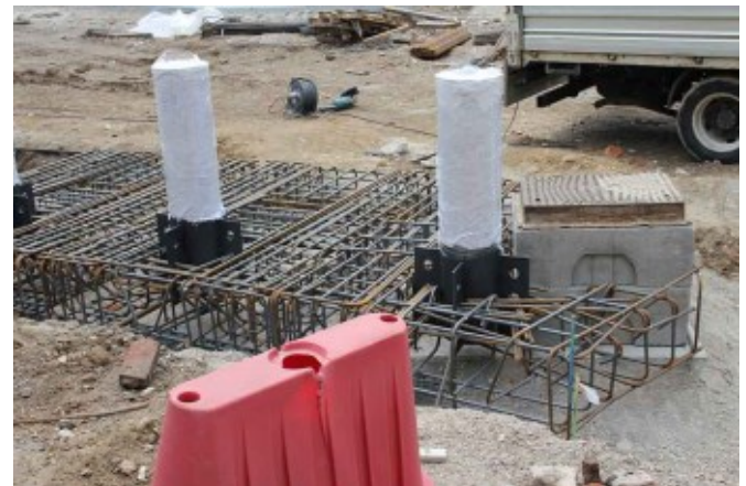
Fig. 123 - Fase intermedia dei lavori di deturpamento del Baluardo Albuquerque: installata la pesante armatura che ingabbia i "milomat".
