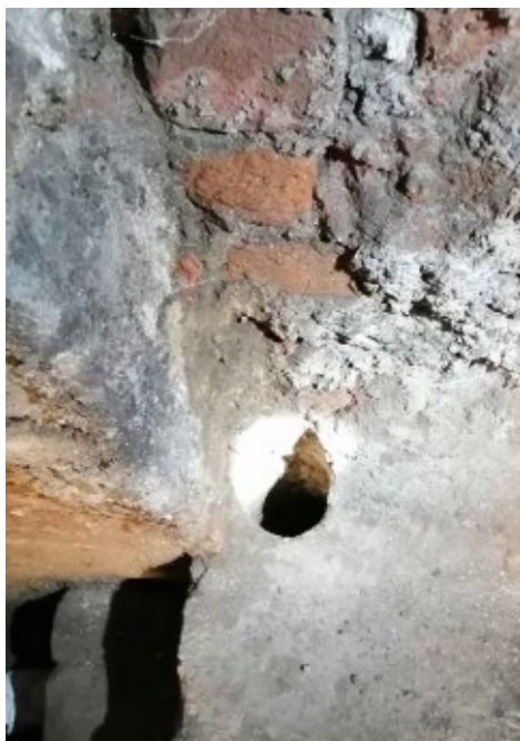
Fig. 66 - Dettaglio del foro dell'interfono.
