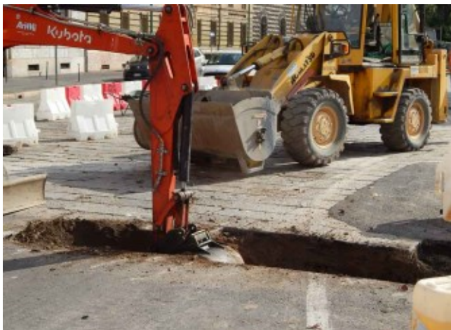
Fig. 36 - Rimane evidente che si stia scavando esattamente sopra il Baluardo Albuquerque, situato appena sotto la pavimentazione stradale, tra Piazza Castello e Via Giovanni Lanza.
