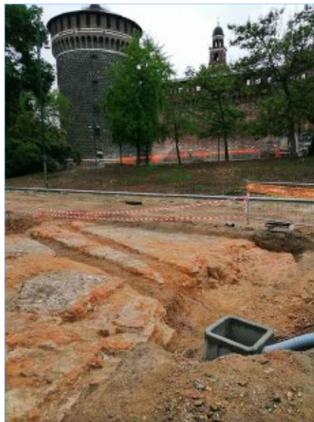
Fig. 144 - 28 luglio: emblematica immagine del cantiere.
