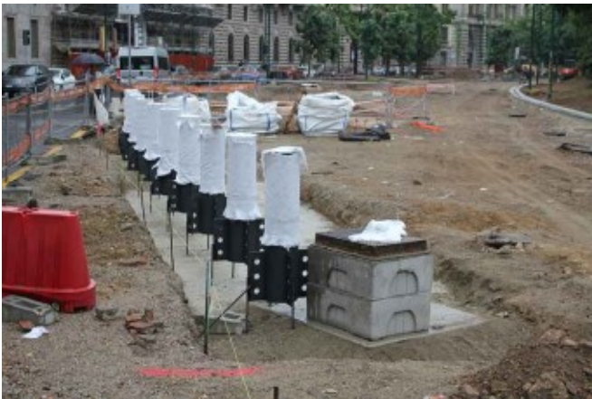
Fig. 122 - La sommità del camino d'aerazione del Baluardo Albuquerque è stata eliminata e si è installato un prolungamento di cemento con il tombino metallico. Accanto, esattamente sulle vestigia del Baluardo rinascimentale, è stato colato un primo strato di cemento e sono stati installati in fila come soldatini i risibili "milomat" costituenti la "barriera antiterrorismo".
