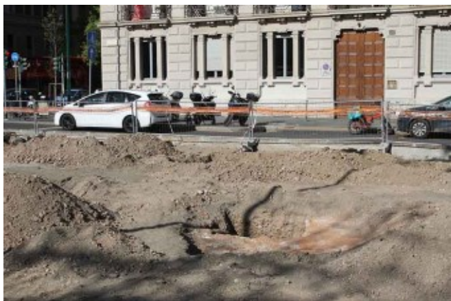
Fig. 101 - Siamo alle solite! Il 11 aprile 2022: in primo piano una delle fosse per piantare l’albero. Con la benna si è messa a nudo e intaccata una porzione del Baluardo Albuquerque facente parte della Fortezza Reale. In alto a sinistra si può riconoscere l’imbocco di Via Giovanni Lanza, ovvero dove nel 2013 già si era intercettato con le ruspe il baluardo rinascimentale. Pensavano che dopo una decina d’anni si fosse dissolto come per magia?
