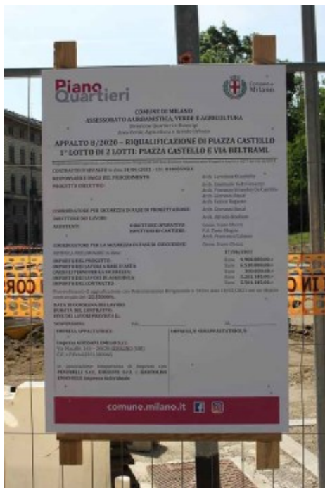
Fig. 148 - Cartello illustrativo d'obbligo installato a lato del cantiere dove si sta rovinando il Baluardo Albuquerque: ma qui parrebbe che per il solo primo lotto di due si spenda assai più dei preventivati e asseverati 12 milioni di euro più IVA per entrambi i lotti.
