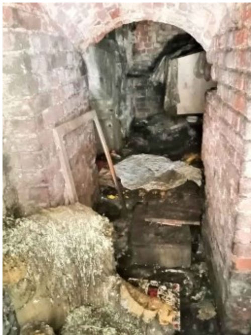
Fig. 68 - Interno del piano terreno delle mura urbane: impossibile accedere ai piani sotterranei a causa del degrado, del fetore e del reale pericolo d'infezioni.
