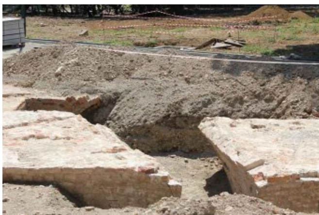
Fig. 133 - 2 agosto: scavo inteso a disseppellire la galleria con il cervello di volta mancante. Non vi è alcun addetto ai lavori ma, come ogni giorno delle scorse settimane, le vestigia del passato non sono protette con i classici teli.
