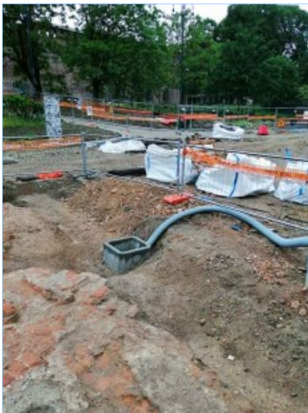
Fig. 143 - 28 luglio: esemplificativa immagine del cantiere.
