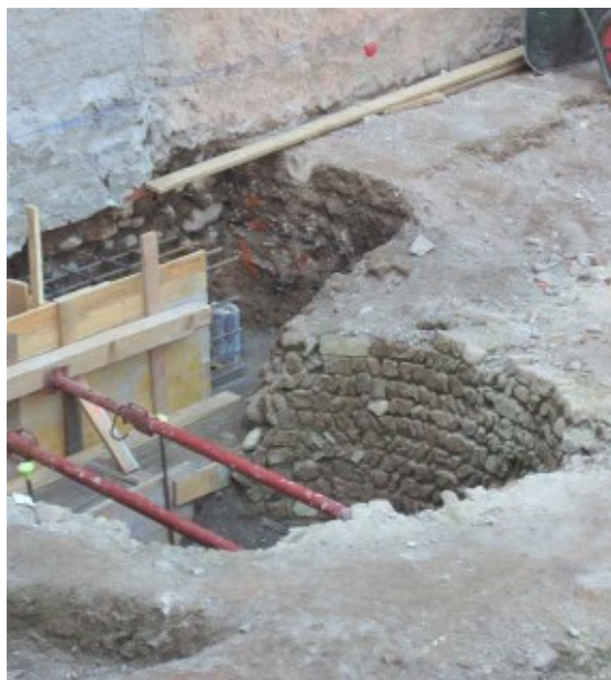
Fig. 21 - Scavi per la realizzazione di un posteggio sotterraneo tra Via Brisa e Via Gorani: esattamente attorno alla famosa Torre dei Gorani e ai resti monumentali del Palazzo Imperiale di Massimiano. Il tutto è stato cancellato invece di ampliare il già esistente micro-parchetto archeologico, per altro inaccessibile al pubblico.
