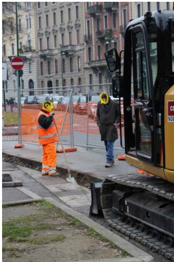
Fig. 41 - Milano 2020: tentativo di posa di tubature in Piazza Castello, di fronte a Via Marco Minghetti; peccato che sotto un paio di spanne d'asfalto e ghiaia vi fossero le bastionature della Fortezza Reale rinascimentale. Gli addetti ai lavori osservano perplessi le solide strutture in mattoni messe in luce dalla benna. Qualche settimana dopo dovrò spendere un paio d'ore per spiegare all'archeologo di cantiere dove non scavare con la ruspa sempre in Piazza Castello, ma di fronte a Via Stefano Jacini.
