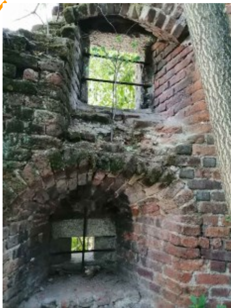
Fig. 149 - Torre del Piombo: interno della capponiera che teneva sotto controllo lo spazio tra Ghirlanda e fossato del Castello. Oggi è un dormitorio-defecatoio-orinatoio e all'occorrenza cassonetto indifferenziato per ogni sorta di sudiciume.
