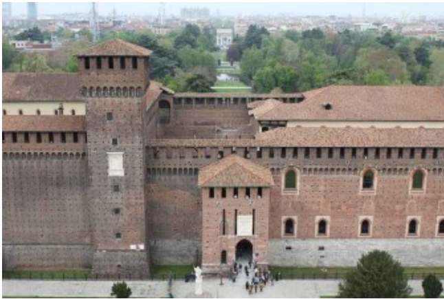
Fig. 48 - Fronte interna del Castello rivolta alla Piazza d'Armi: a sinistra abbiamo la Rocchetta con la Torre voluta da Bona di Savoia, la Porta-torre (erroneamente denominata "battiponte") e la Corte Ducale a destra. Sullo sfondo si scorge Parco Sempione, ovvero il Barcho medievale. Alcuni anni fa hanno "restaurato" il lato destro, ovvero quello della Corte Ducale, ma solo fino ai beccatelli. Risultato: la parte antica pare nuova e i ricostruiti beccatelli, le caditoie e la copertura sembrano antichi.
