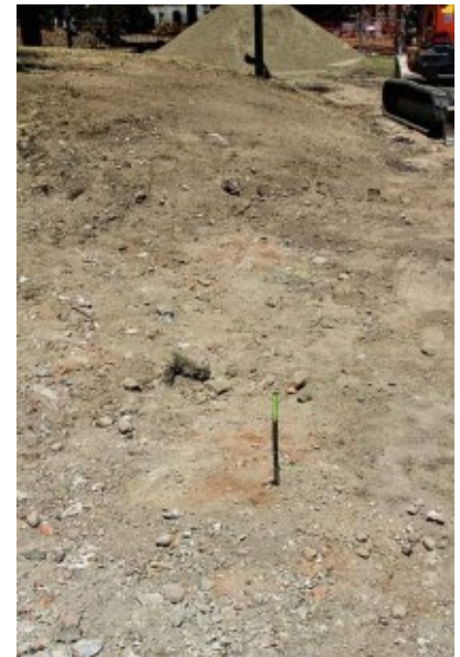
Fig. 145 - L'immagine potrà apparire anche banale, ma documenta come la benna della ruspa si sia arrestata appena in tempo. Difatti, sotto il picchetto, cominciano ad apparire le vestigia del Baluardo San Jago, sempre facente parte della Fortezza Reale.
