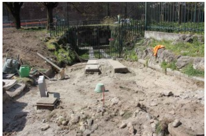
Fig. 127 - 14 aprile 2022: tale lavoro era proprio necessario? Senza contare che sotto vi sono ambienti ancora da esplorare.
