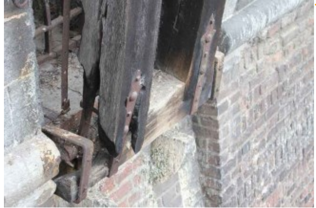
Fig. 153 - Ponticella levatoia pedonale di collegamento con il rivellino: gli elementi lignei sono parzialmente bruciati e, dal momento che sono così da almeno mezzo secolo, è probabile che siano i "testimoni" dell'incendio del Castello avvenuto a seguito dei bombardamenti subiti nel corso della Seconda Guerra Mondiale.
