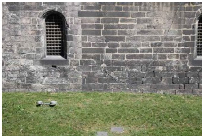
Fig. 152 - Scarpa in conci d'epoca viscontea: lungo le mura del Castello vi sono decine e decine di cavi che corrono, pendono e spesso finiscono nel nulla perché non sono utilizzati.
