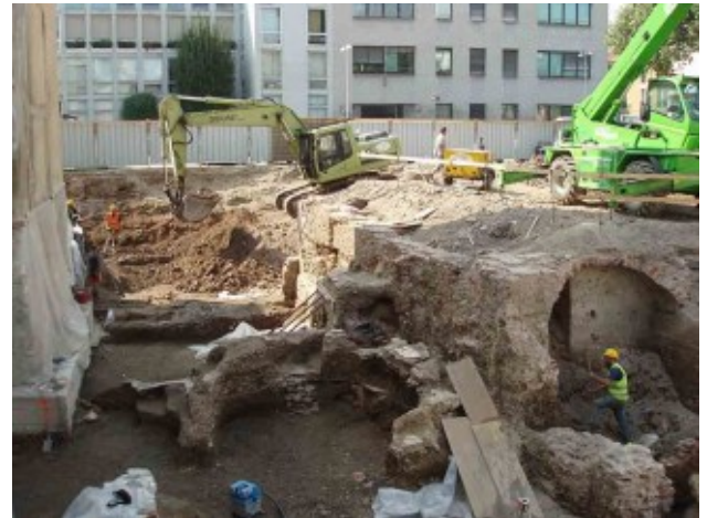
Fig. 23 - Via Brisa: strutture antiche perfettamente integre vengono abbattute a colpi di benna e di piccone (si noti l'operaio alla destra dell'immagine).
