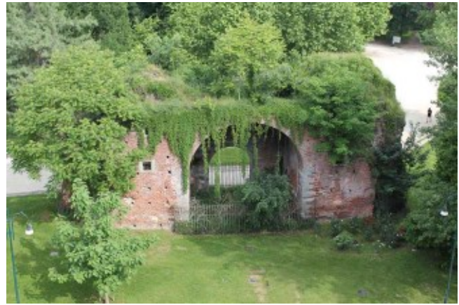
Fig. 49 - Il Castello rimaneva a cavallo delle mura urbane e la parte rivolta all'esterno (oggi Parco Sempione) era protetta da una cinta dotata di torri cilindriche e denominata da Leonardo da Vinci "ghirlanda"; la foto ne inquadra la Porta del Soccorso.
