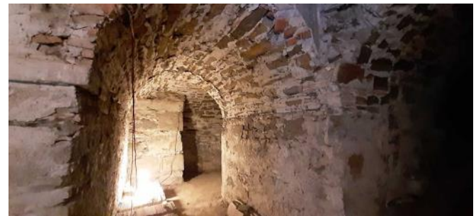
Nella seconda parte le cripte sono costituite da gallerie con pietre di arenaria a vista.
