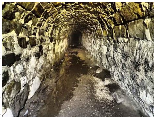
L’antica galleria della “grapa” che si trova sotto il livello stradale e che scorre parallelamente tutta la via Petrarca, a Gorizia, prima di gettarsi a valle nel torrente Corno.
