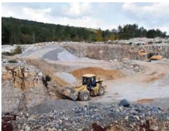
I grandi lavori in cantiere per il raddoppio della linea ferroviaria Capodistria-Divaccia.
