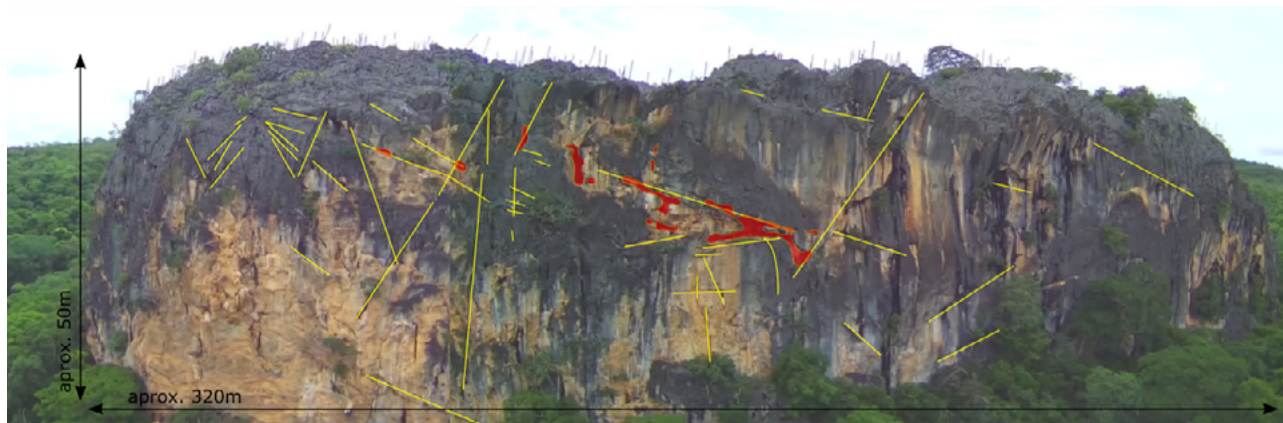
Figura 9: Imagem da vertente leste do morro. Em amarelo estão demarcadas estruturas planares. Intersecção de planos geram aumento significativo da permeabilidade do maciço promovendo o desenvolvimento de condutos (polígonos vermelhos).
