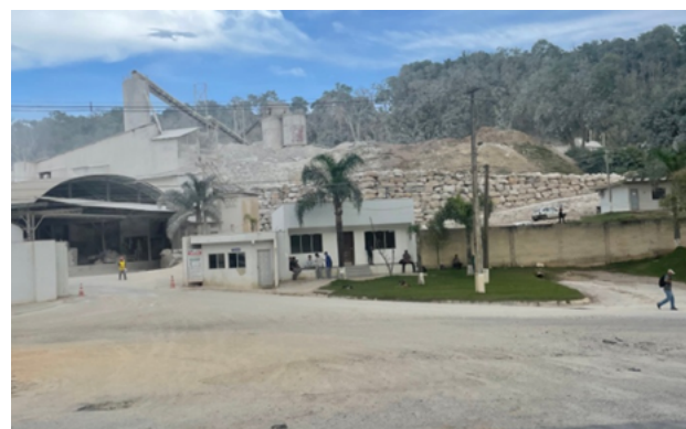
Figura 5: poluição resultante do processamento de rochas carbonáticas para a fabricação de cal cobrindo a vegetação e as infraestruturas adjacentes - Almirante Tamandaré-PR. Fonte: autores.
