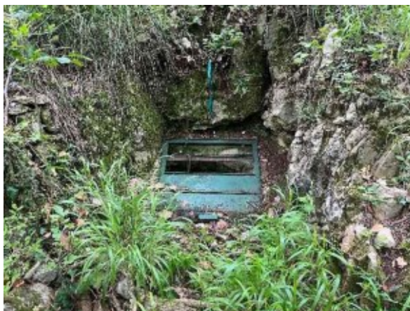
La botola posta a chiusura dell'ingresso Sardoc.
