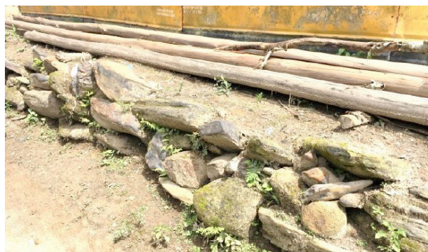
Alicerces antigos de alvenaria de pedra sob moradias atuais na Comunidade Negra Rural “Quilombo”. Ouro Preto. Foto: A. Baeta, 2024.
