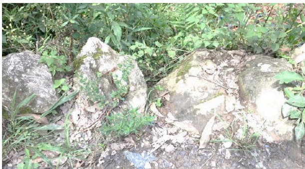
Alicerces antigos de alvenaria de pedra sob moradias atuais na Comunidade Negra Rural denominada “Quilombo”, Ouro Preto. Foto: A. Baeta, 2024.
