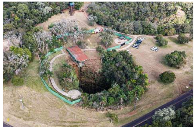
Elevador da furna do Parque Vila Velha está sendo revitalizado — Foto: Gabriel Fiori/Governo do Paraná
